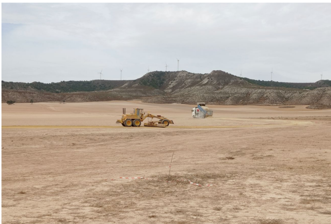
Figura 2a Trabajos de acondicionamiento de viales
