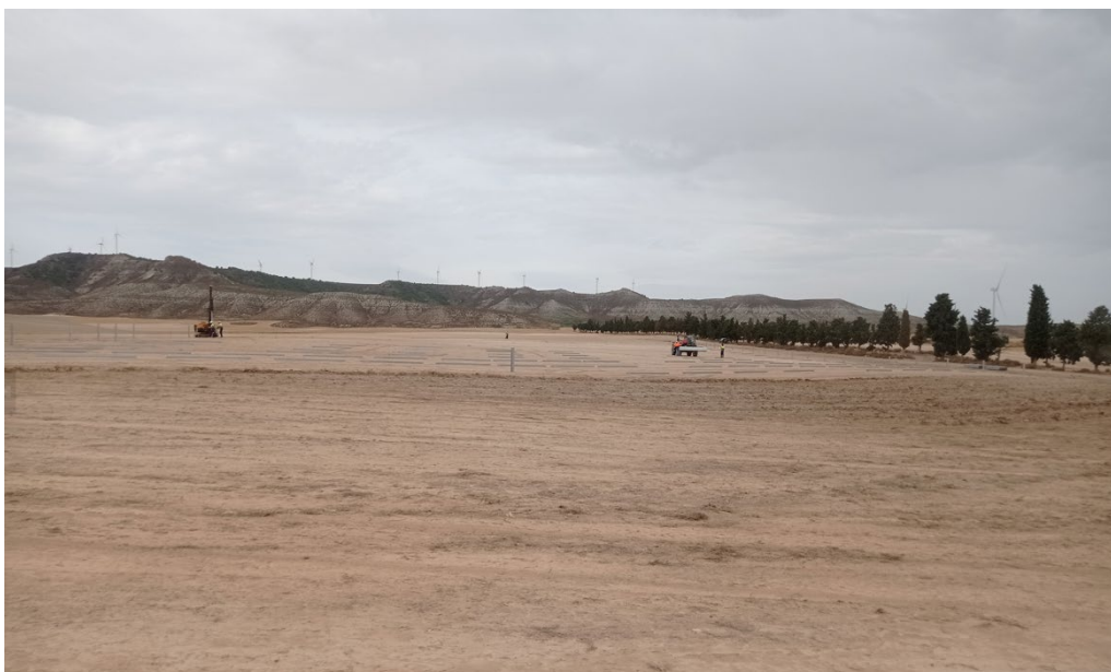
Figura 8 Trabajos de hincado en PFV Vallobar
