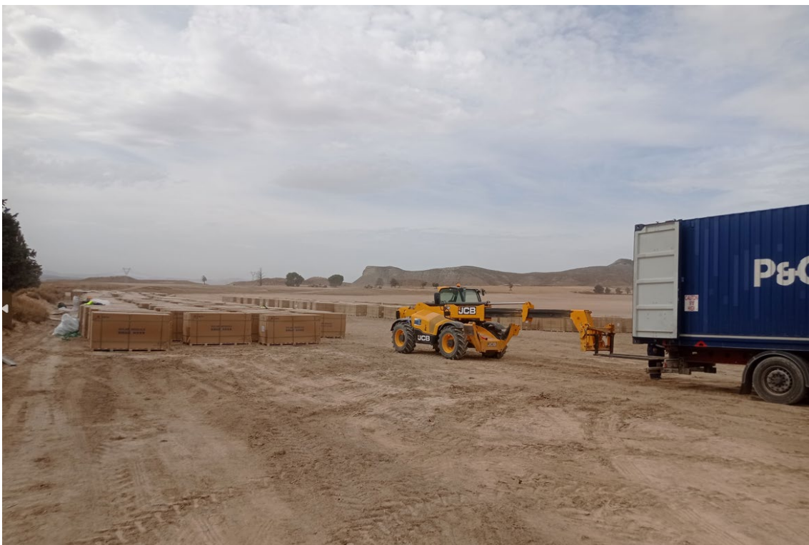
Figura 4 Zona de acopio general
