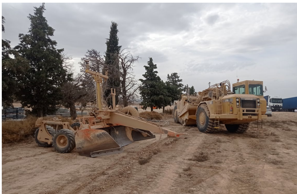
Figura 7 Maquinaria de movimiento de tierras
