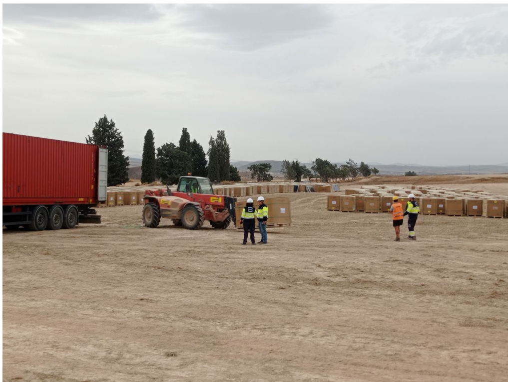
Figura 7 Zona de acopio de placas fotovoltaicas
