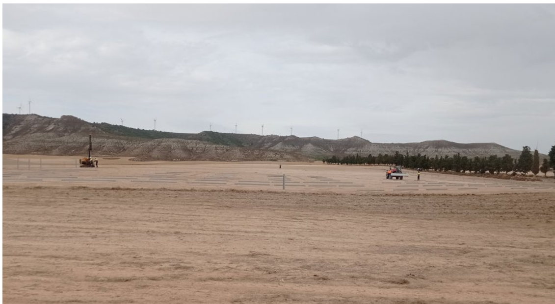
Figura 2b Inicio trabajos de hincado
