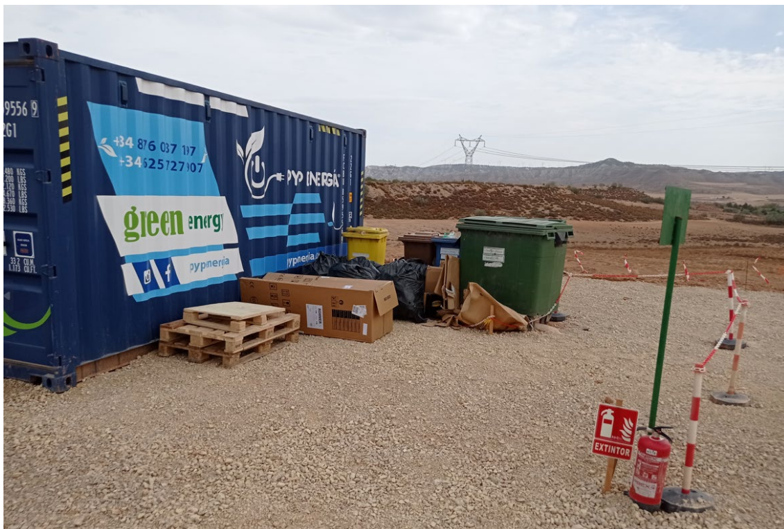
Figura 3 Punto limpio de residuos no peligrosos
