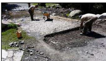
Preparación de la pista del Vado para el bacheado del asfaltado en frío.
