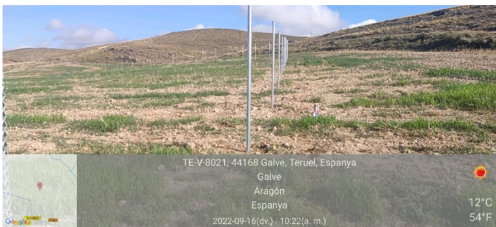
Ilustración 7. Primer montaje del vallado con pasos de fauna.
