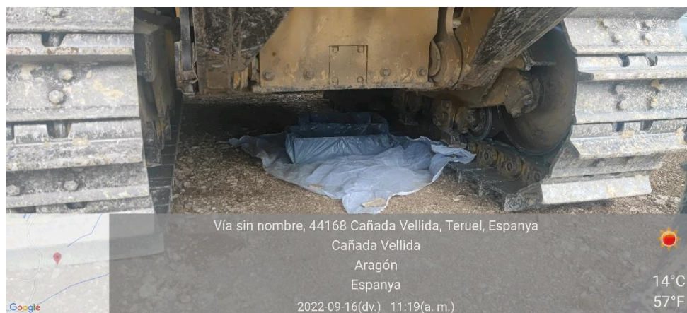
Ilustración 9. Plásticos protectores bajo maquinaria.
