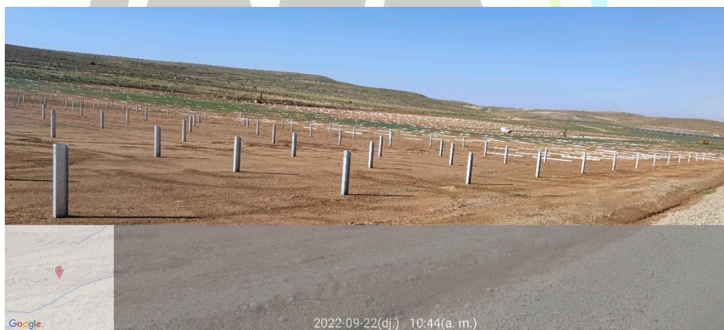
Ilustración 11. Hincas de seguidores en la zona 2.
