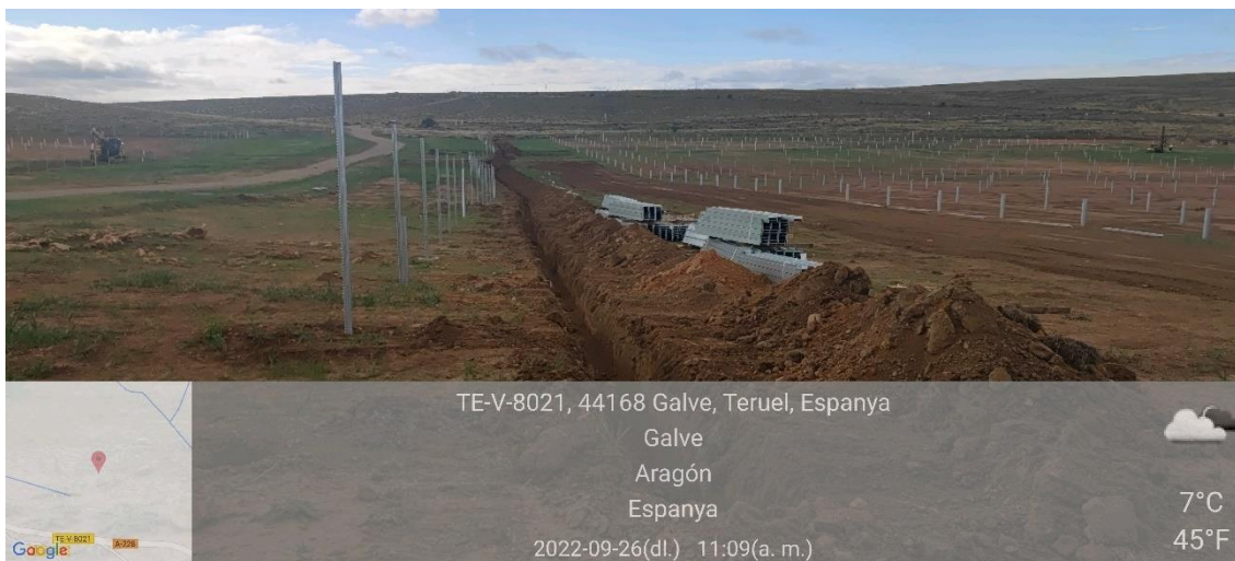
Ilustración 17. Apertura de zanjas de media tensión junto al vallado de la zona 1 (arriba) y zona 2 (abajo).
