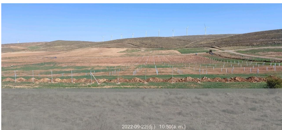
Ilustración 12. Vallado y apertura de zanjas de media tensión junto al mismo en la zona 2.
