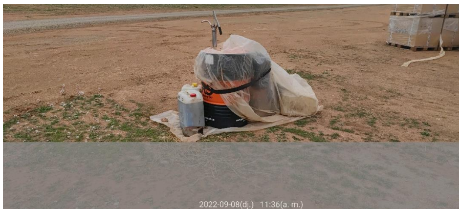
Ilustración 6. Plástico protector bajo bidones con gasolina.
