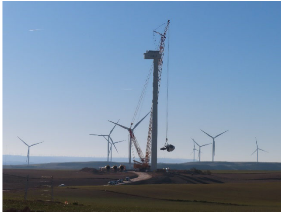
Montaje aerogenerador REA-03.
