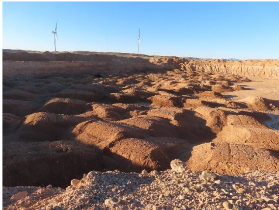
Préstamo de tierras rellenado con tierras de excavación.
