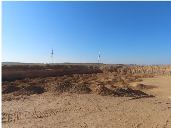
Área de préstamo de tierras rellena con tierras desechadas de la propia obra.
