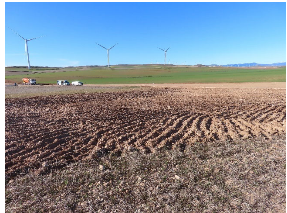
Superficie del área de maniobras anterior descompactada.
