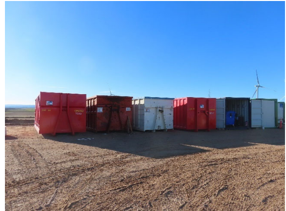
Punto limpio de Siemens-Gamesa. Contenedores de residuos no peligrosos.
