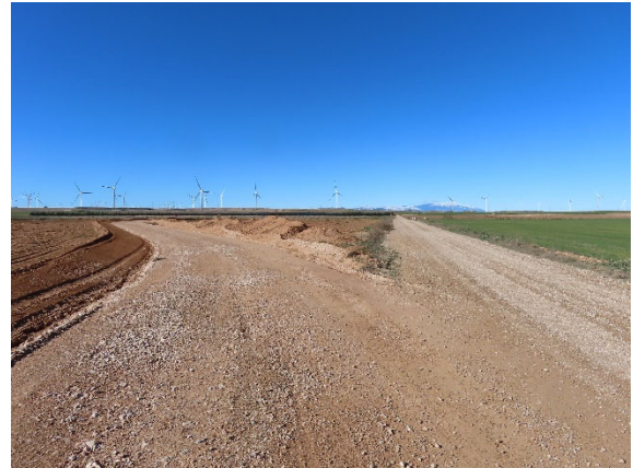
Curva del camino de acceso por el PI, acondicionada para los transportes especiales, que será desmantelada al finalizar la obra.
