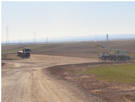
Área de maniobra en acceso al aerogenerador REA-03.
