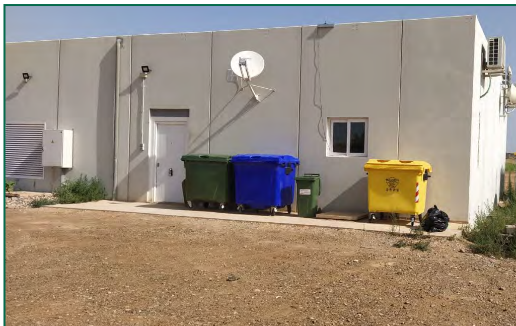
Fotografía 17. Contenedores de residuos no peligrosos en el exterior del centro de control.
