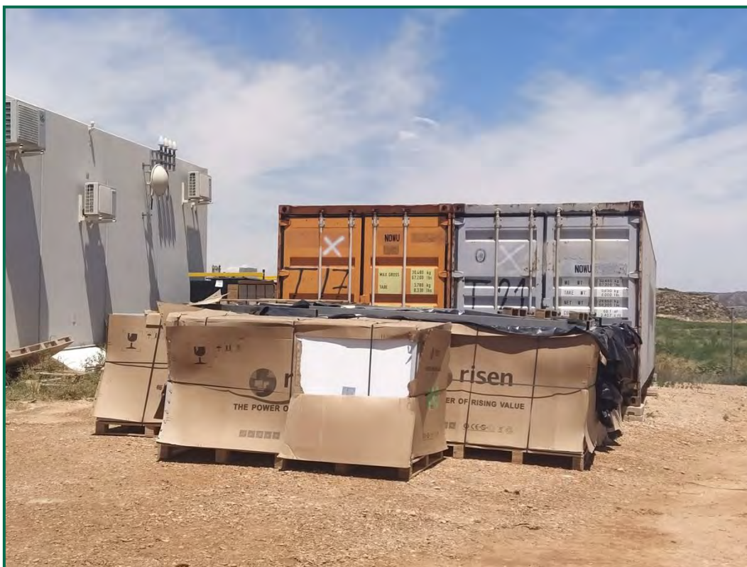
Fotografía 18. Placas solares deterioradas almacenadas en el exterior del centro de control.
