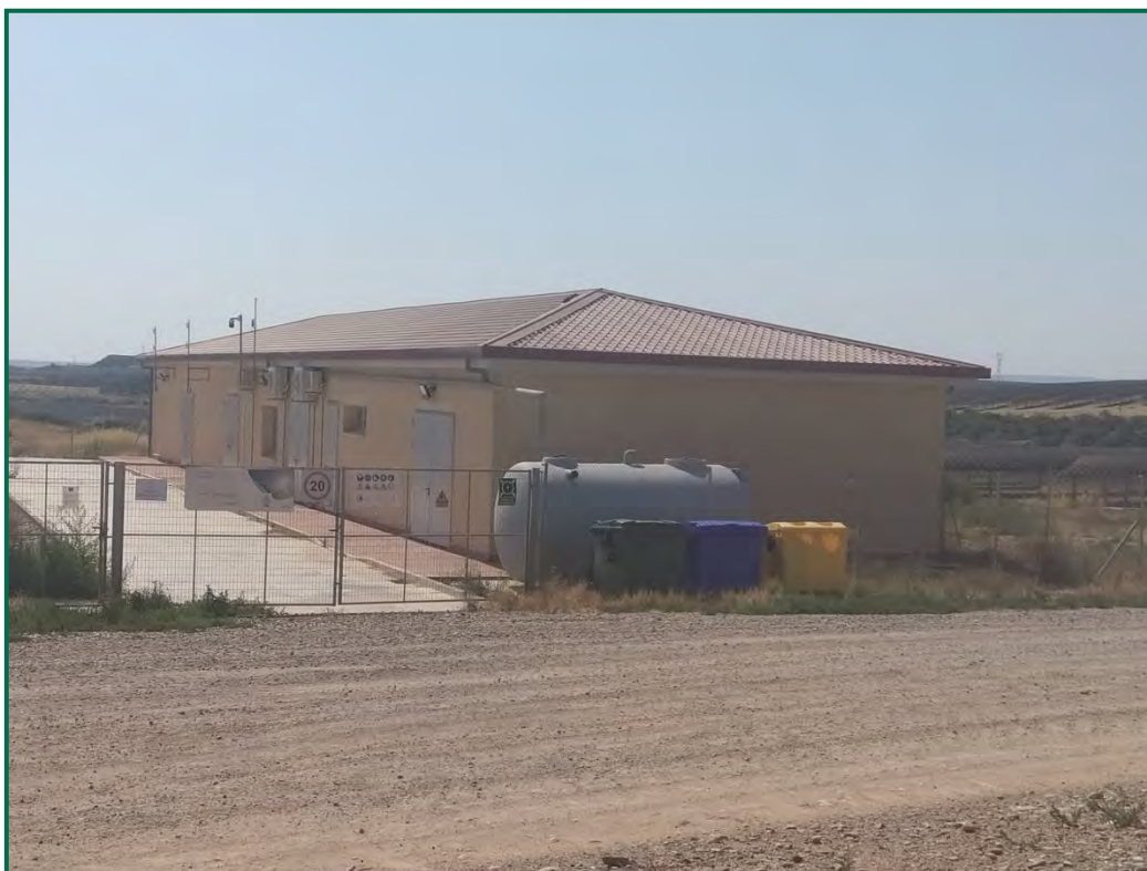
Fotografía 16. Contenedores de residuos no peligrosos en exterior de la subestación.
