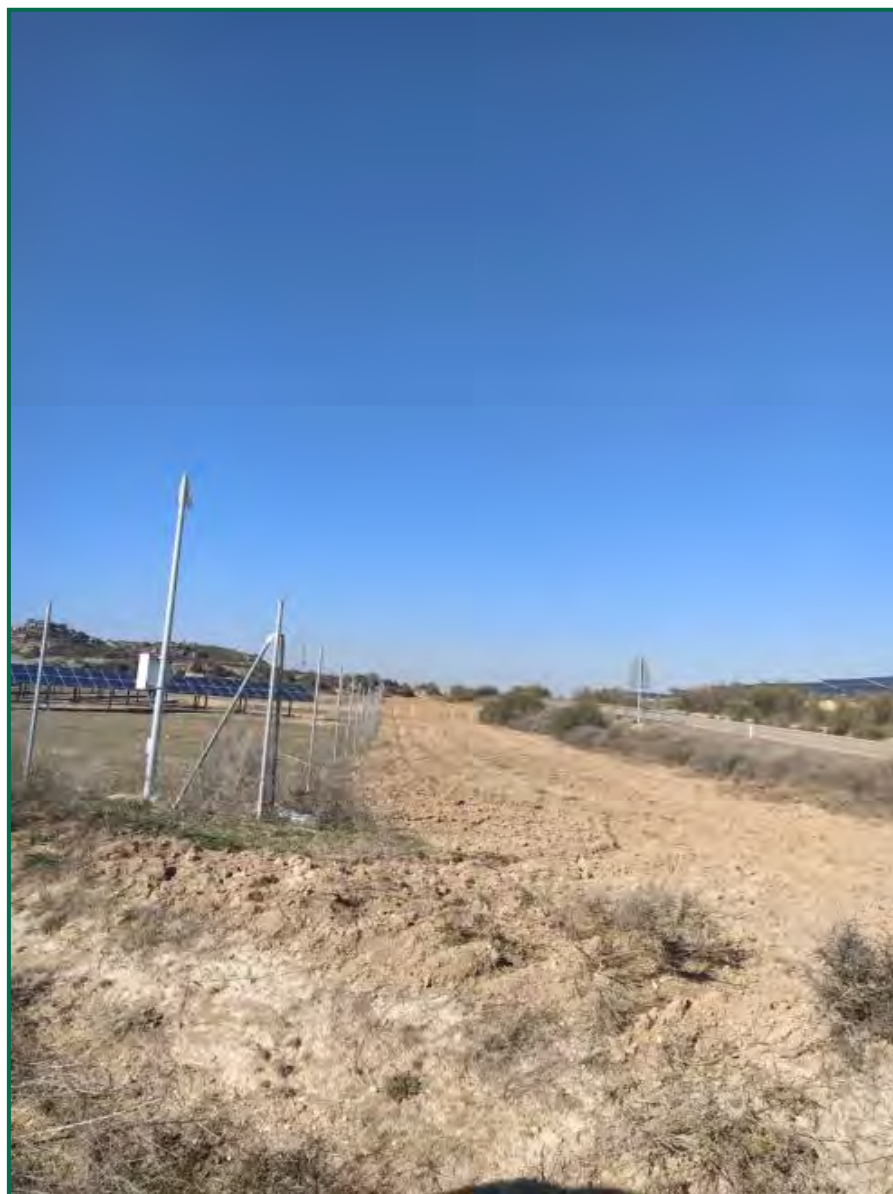
Fotografía 4. Estado posterior (enero 2022) de la misma zona
