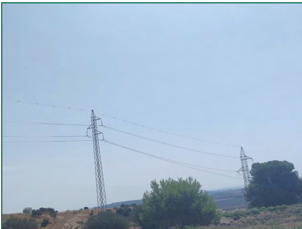
Fotografía 6. Línea eléctrica con balizas salvapájaros
