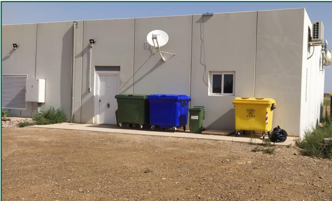
Fotografía 12. Contenedores de residuos no peligrosos en el exterior del centro de control.
