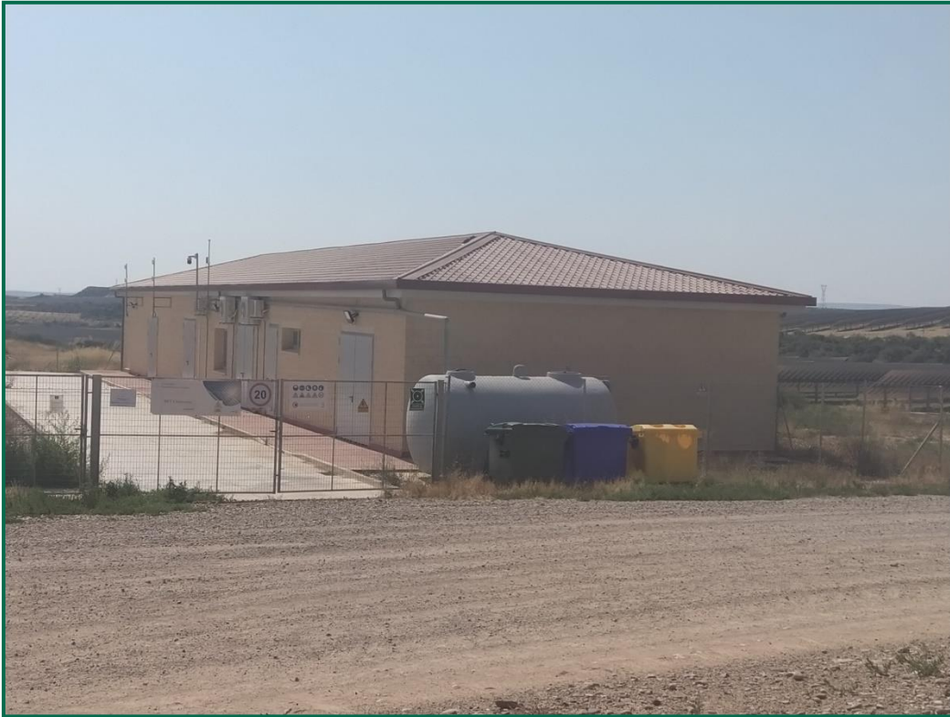
Fotografía 11. Contenedores de residuos no peligrosos en exterior de la subestación.
