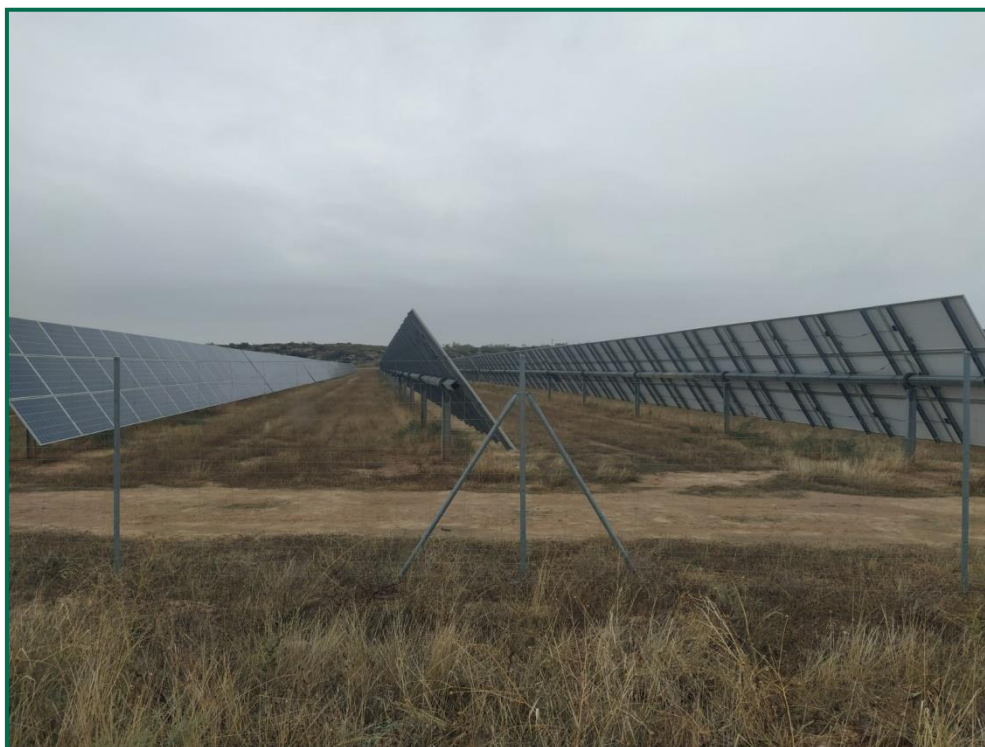
Fotografía 1. Vegetación entre placas actualmente.
