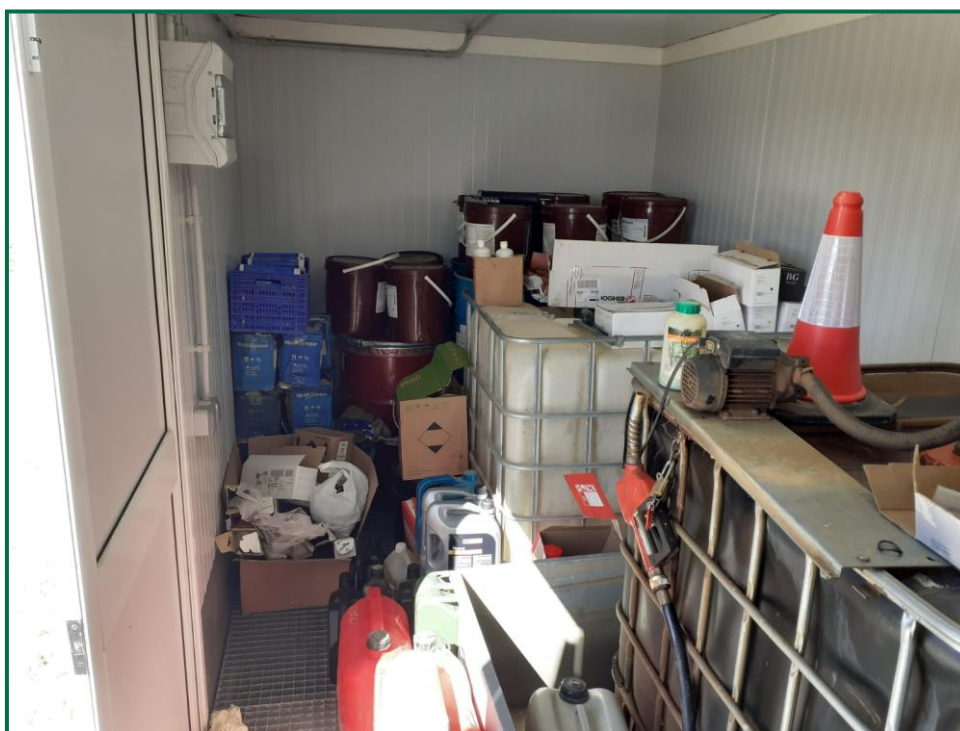
Fotografía 5. Bidones para residuos peligrosos.
