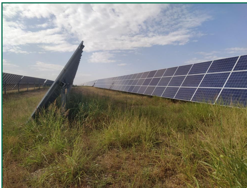
Fotografía 1. Vegetación entre placas en su estado actual.
