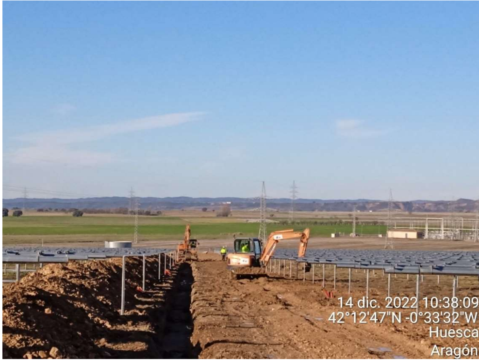
Imagen 5. Trabajos en las zanjas y conducciones de baja tensión.
