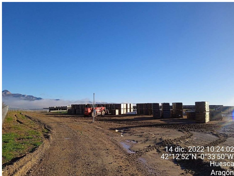
Imagen 8. Máquina repartiendo los módulos fotovoltaicos almacenados.
