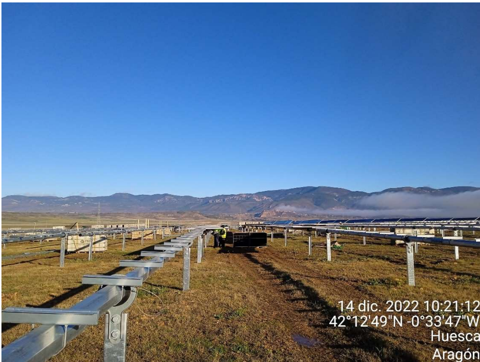
Imagen 6. Trabajos de instalación de los módulos fotovoltaicos.
