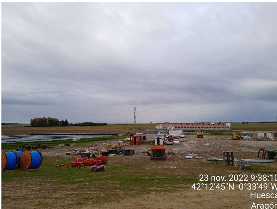
Imagen 12.- Vista general de la zona de Instalaciones auxiliares.
