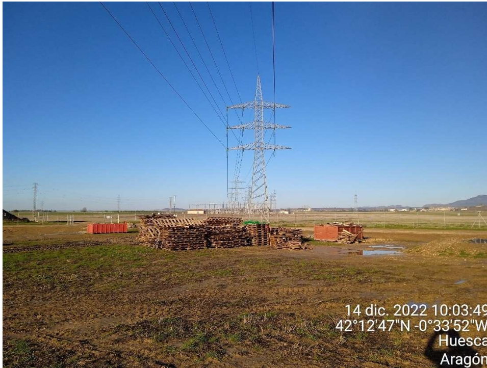
Imagen11.- Punto limpio de Residuos no peligrosos.
