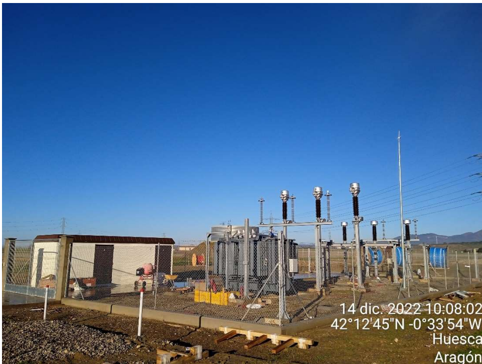
Imagen 10.- Trabajos en la Subestación de Transformación.
