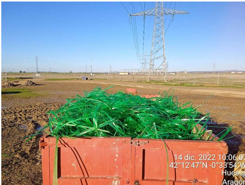
Imagen 12.- Contenedor de plásticos en el Punto limpio de Residuos no peligrosos.
