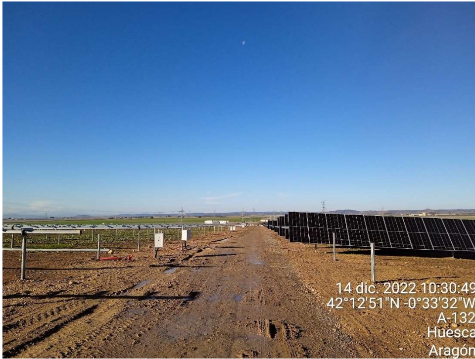
Imagen 7. Avance de los trabajos de instalación de los módulos fotovoltaicos.
