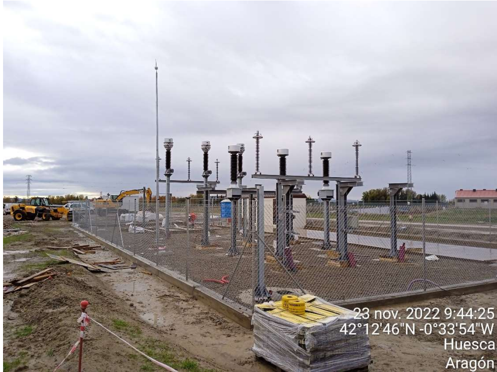
Imagen 13.- Trabajos en la Subestación de Transformación.
