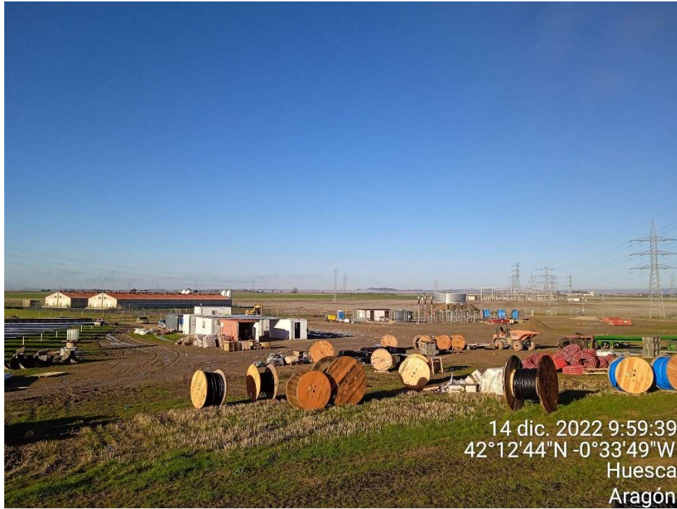
Imagen 9.-Primeros módulos fotovoltaicos instalados, Zona de instalaciones auxiliares y S.E.T.
