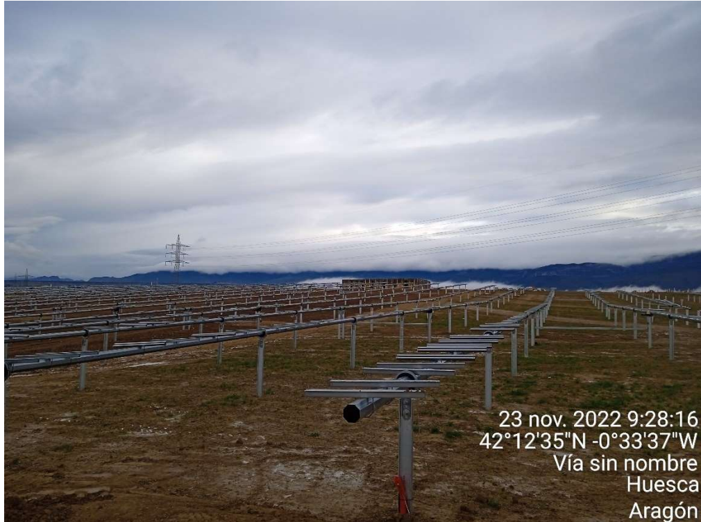
Imagen 5. Montaje de los seguidores de los módulos fotovoltaicos.
