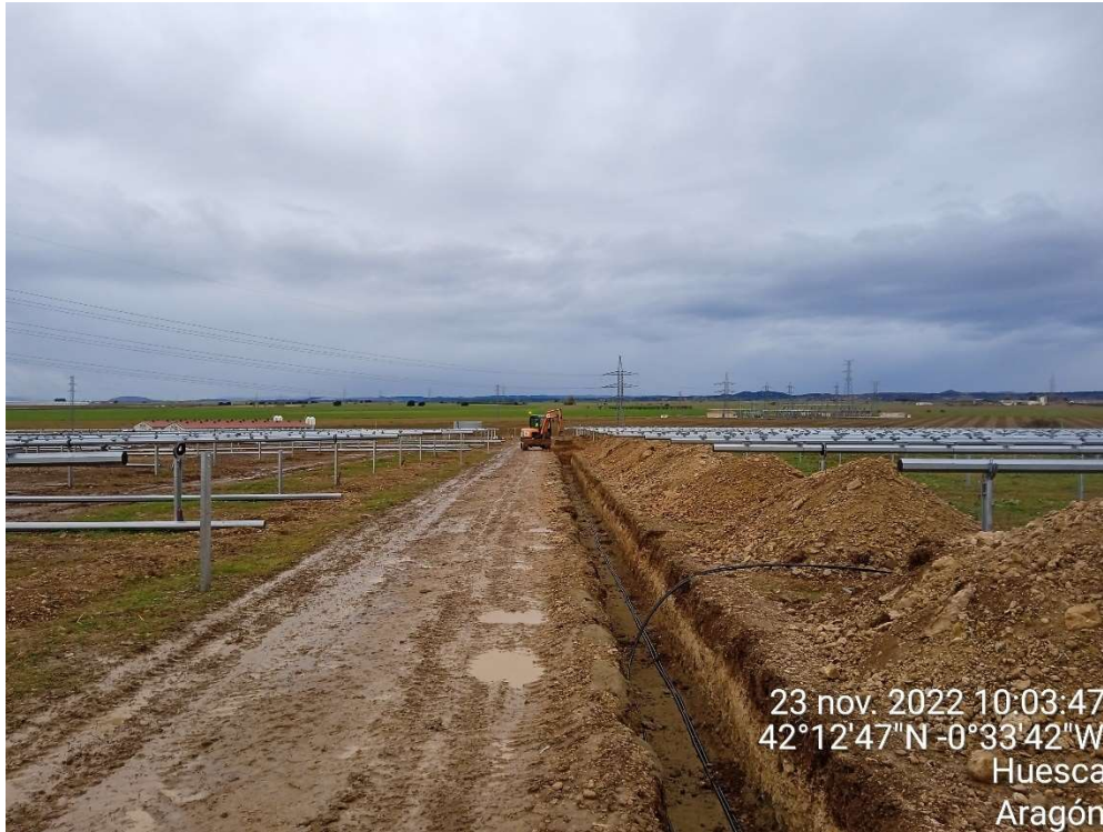
Imagen 7. Trabajos en las zanjas y conducciones de baja tensión.
