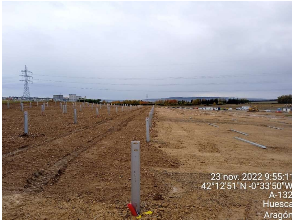
Imagen 1. En la parte izquierda del terreno se ven los postes de los seguidores ya hincados y el suelo cubierto con la nueva capa de tierra vegetal
