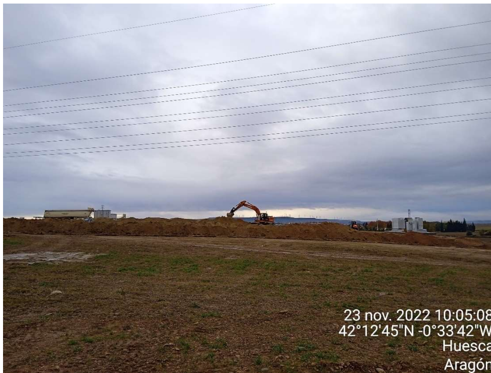
Imagen 8. Máquina preparando las zanjas para las conducciones de baja tensión.
