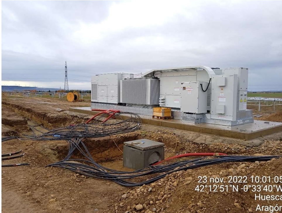
Imagen 11.-Trabajos de conexión del cableado de baja tensión a uno de los 3 C.T.s.
