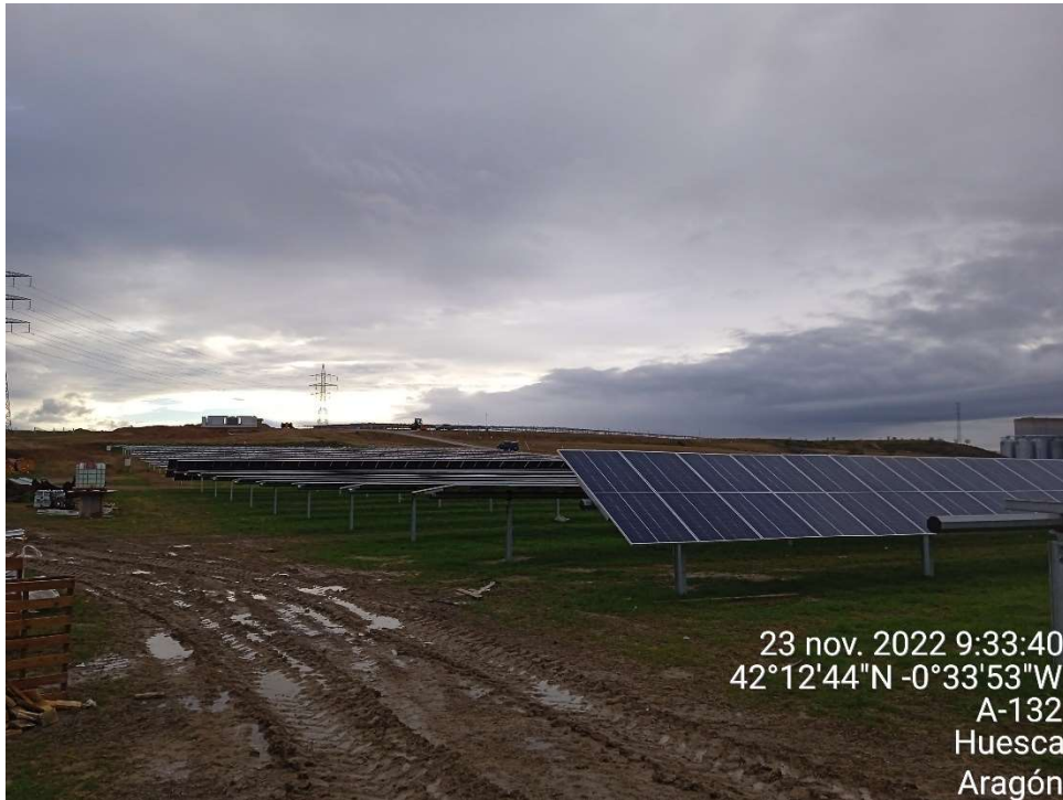
Imagen 9.-Primeros módulos fotovoltaicos instalados al lado de la Zona de instalaciones auxiliares
