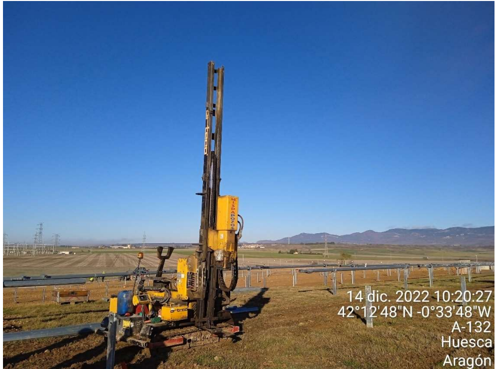
Imagen 3. Máquina hincadora clavando los postes de los seguidores.
