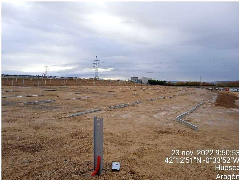
Imagen 4. Últimos postes de los seguidores de los módulos fotovoltaicos preparados para su hincado.
