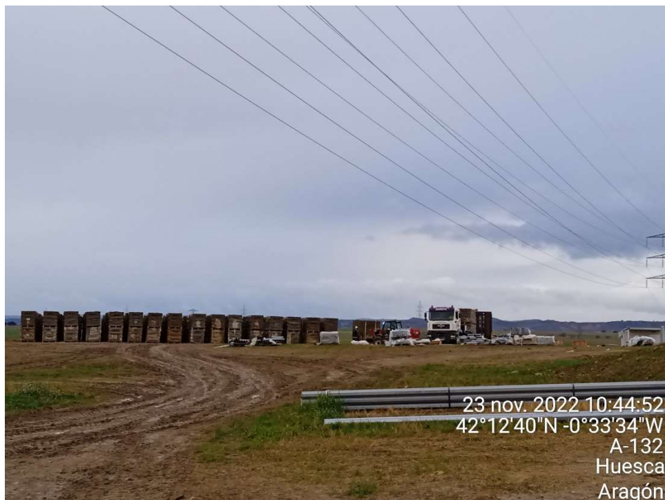
Imagen 10.-Descarga de palets con los módulos fotovoltaicos.
