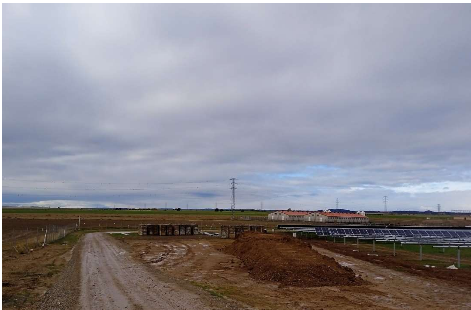
Imagen 2. Cordón de tierra vegetal acopiada. A su derecha los primeros módulos fotovoltaicos colocados.
