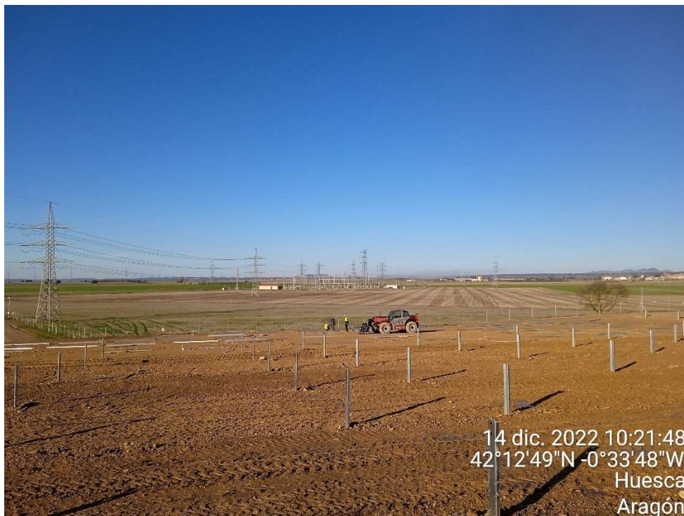
Imagen 2. Trabajos en la última zona en la que se están colocando los postes de los seguidores.
