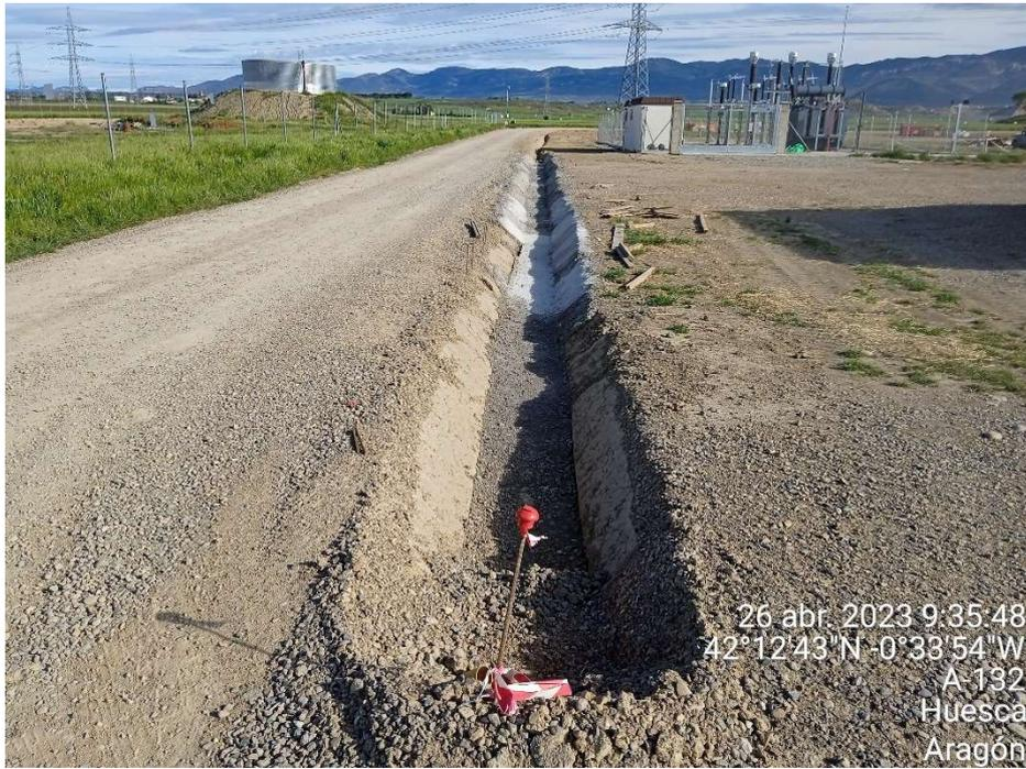
Imagen 13.- Trabajos de construcción de cunetas trapezoidales.
