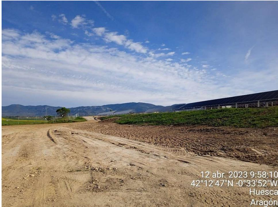
Imagen 3.- Talud restaurado después del extendido de tierra vegetal.
