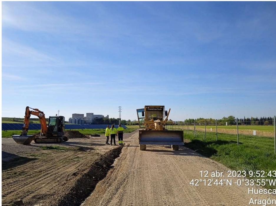
Imagen 13.- Máquinas preparadas para la construcción de cunetas y vados.
