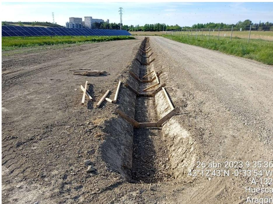
Imagen 12.- Trabajos de construcción de cunetas.
