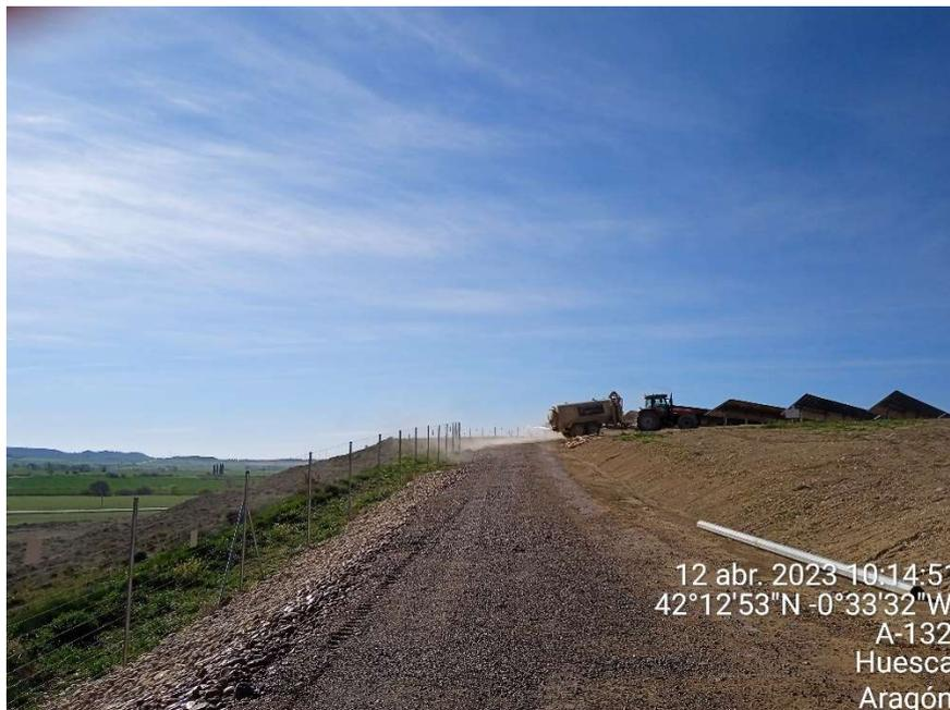
Imagen 12.- Tractor con cuba trabajando en el acondicionamiento de viales.
