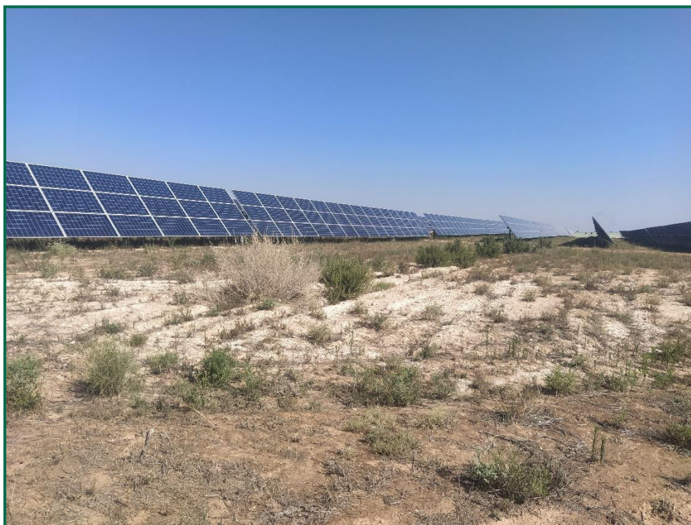
Fotografía 2. Zona revegetada en su estado actual.
