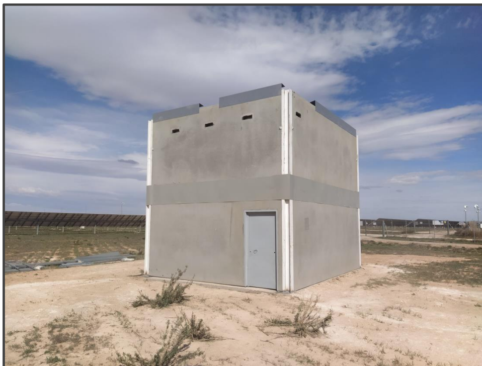
Fotografía 4. Exterior del primillar de nueva construcción.
