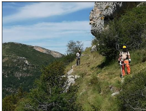
Trabajos de desbroce en sector Alto Vero.
