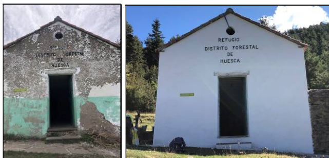
Fachada principal del refugio antes y después de los trabajos de acondicionamiento.
