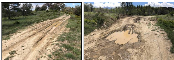
Estado de la pista antes de la realización de los trabajos.
