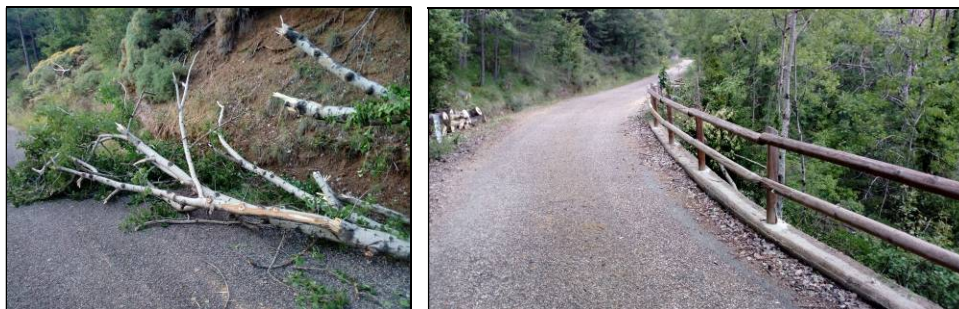
Corte y retirada de árboles caídos en la pista forestal de Nocito a Molino Villobas.
