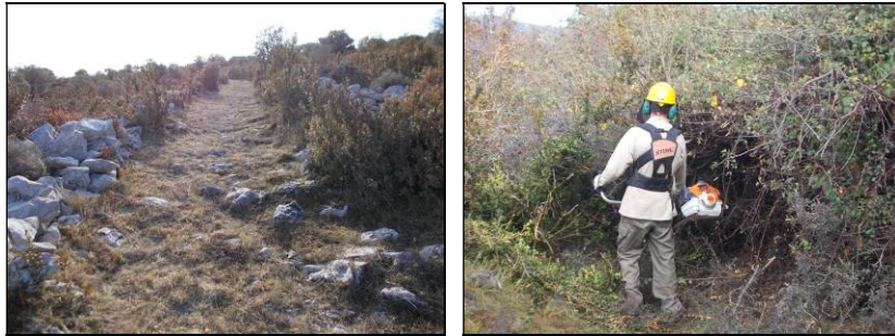
Senda de Paules a Almazorre, trabajos de desbroce.
