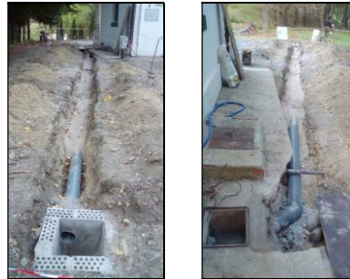
Reparación desagüe debido rotura por raíces de árboles en el CI de Arguis.
