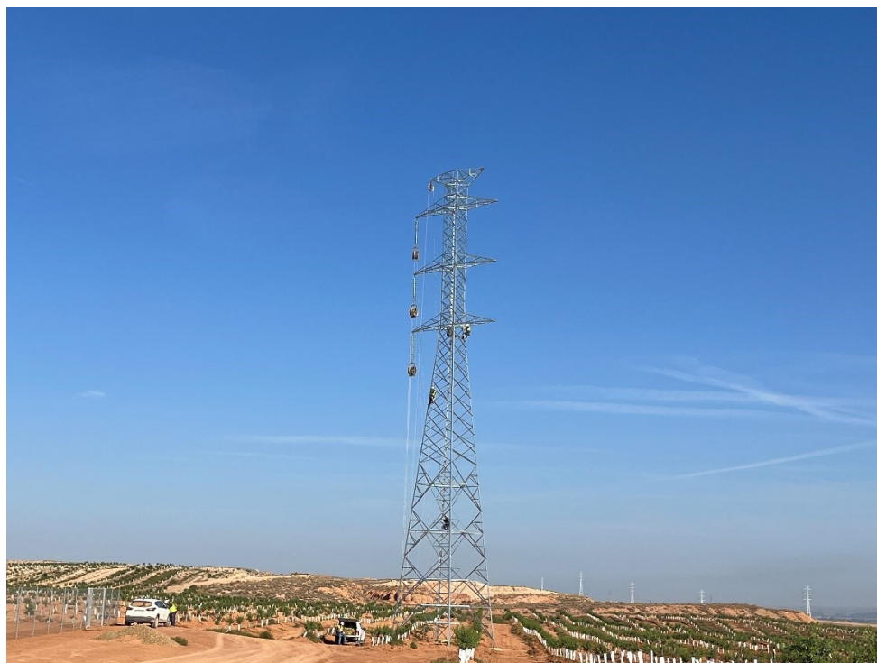
Figura 8 Preparación para el tendido de cable de alta tensión
