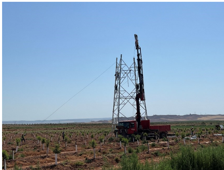
Figura 4 Montaje del apoyo 15
