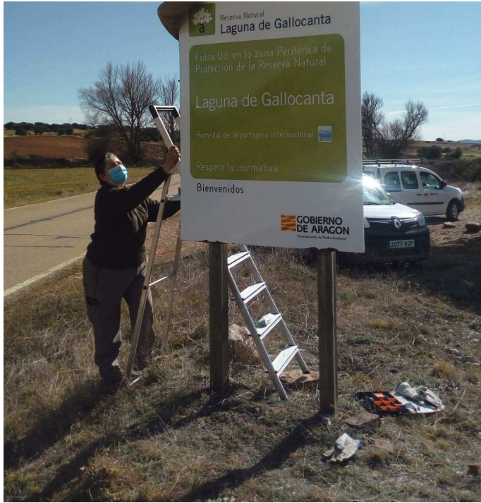
Colocación de una señal que se había caído .
