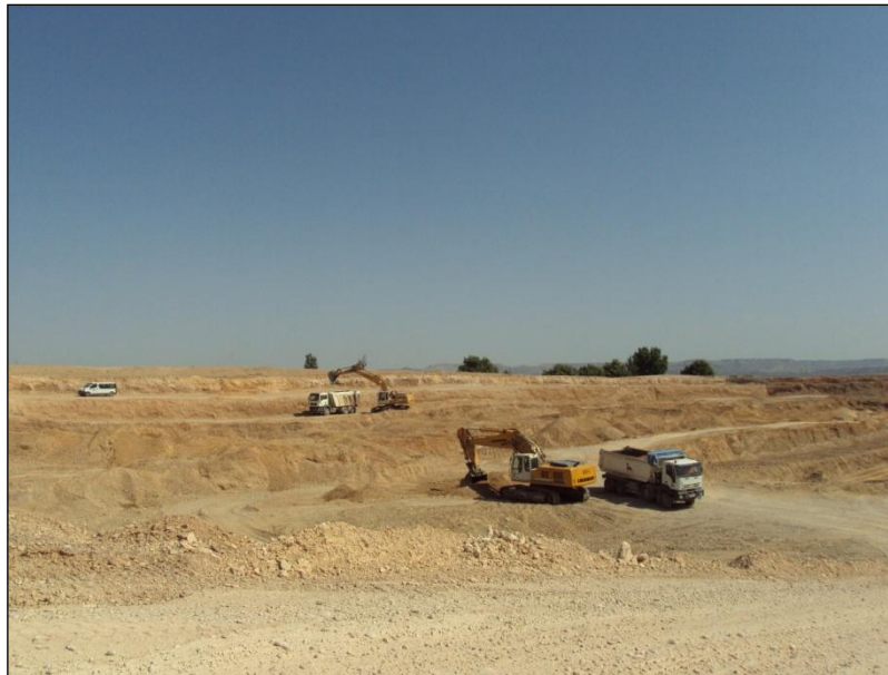
Fotografía 1.- Vista de la operación. Se observa lo indicado en la memoria. Bancos de operación de 3,5 metros para llegar a los bancos finales de 14 metros, con bermas de anchura mínima de 6 metros.
