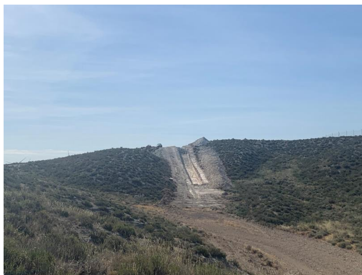
Figura 2 Excavación apoyo para soterrar apoyo 31
