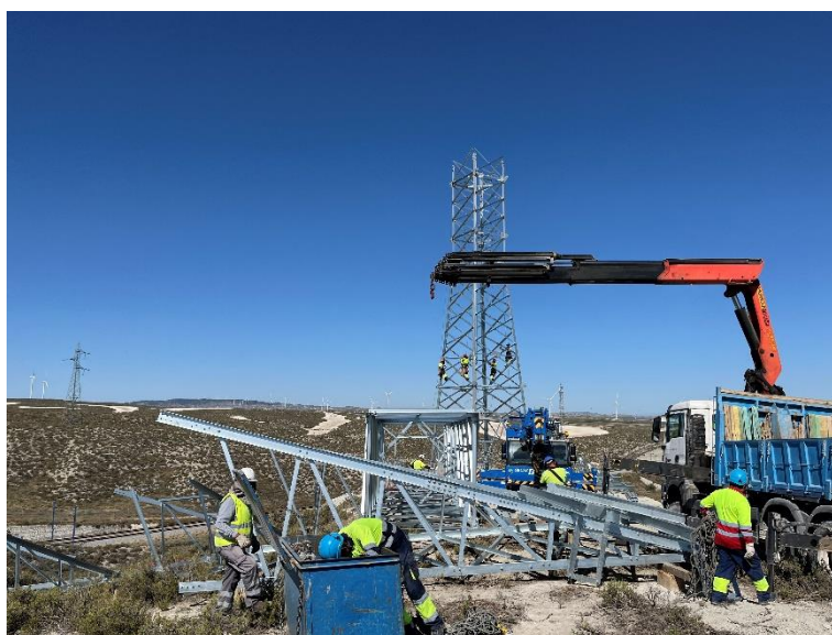
Figura 4 Izado de los apoyos
