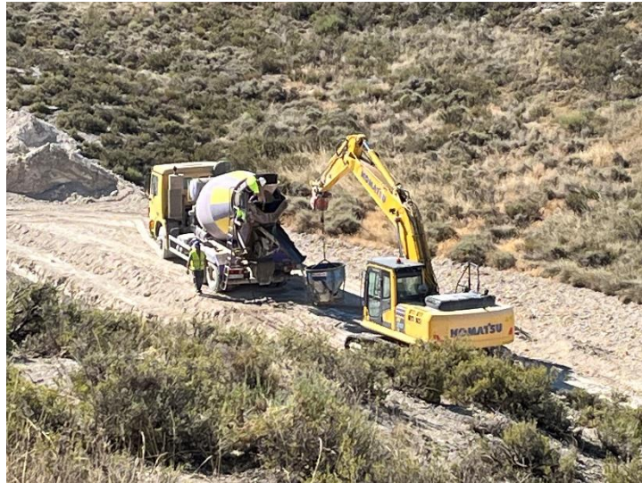
Figura 3 Hormigonado del apoyo soterrado
