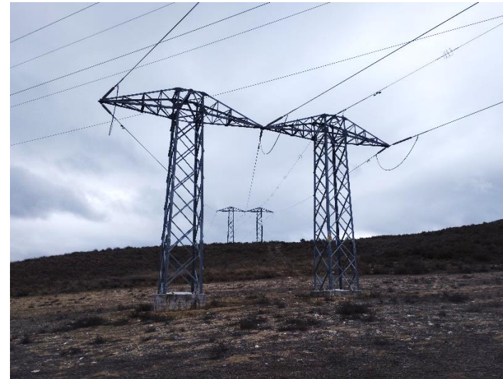
Fotografías 5 a 7: Apoyos de celosía y tendido con salvapájaros
