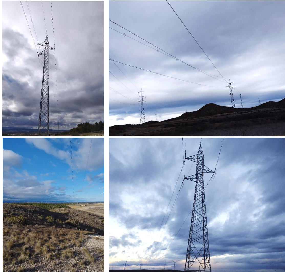
Fotografías 1 a 4: Visibilidad línea de tensión
