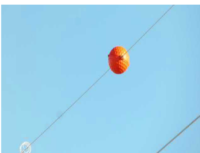
Imágenes 1 y 2. Estado de conservación de baliza esférica (Izquierda), y aisladores (derecha)
