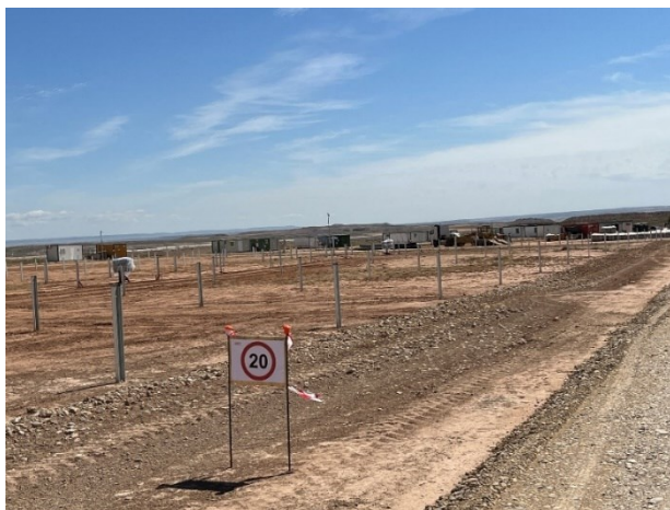
Figura 3 Señalización en obra
