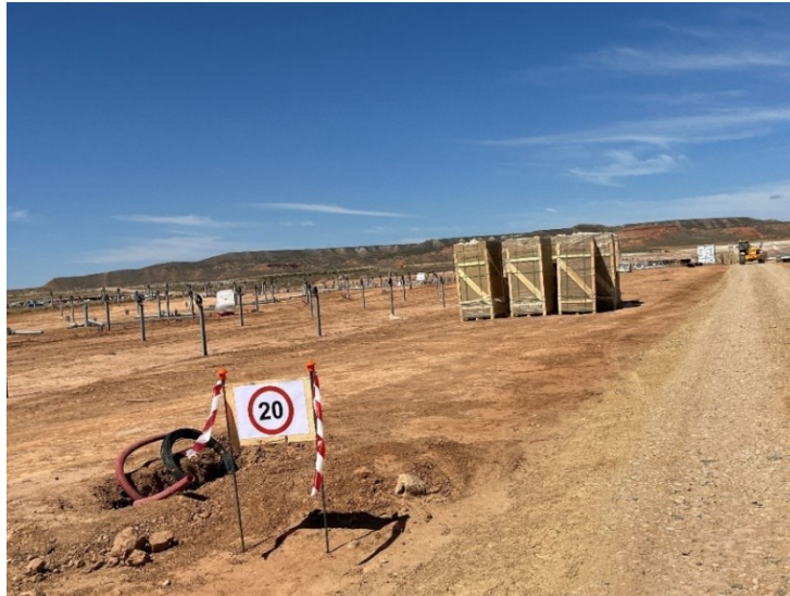
Figura 3 Señalización en obra
