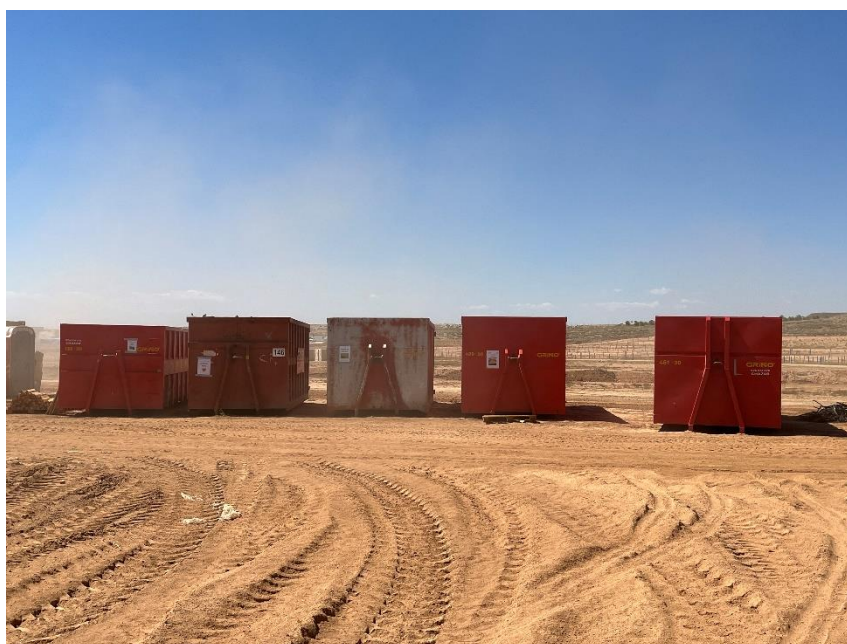
Figura 3 Punto limpio de RNP dispuesto dentro de la planta
