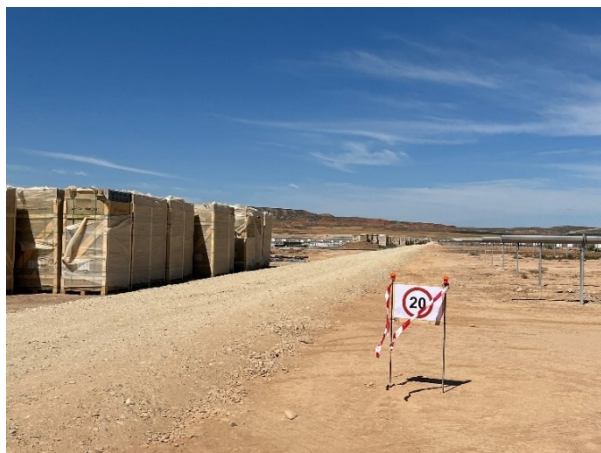
Figura 2 Señalización en obra
