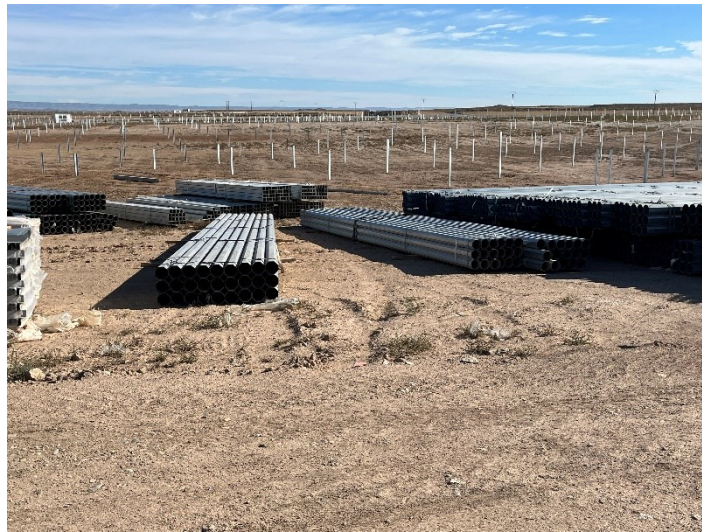
Figura 4 Acopio de material de construcción
