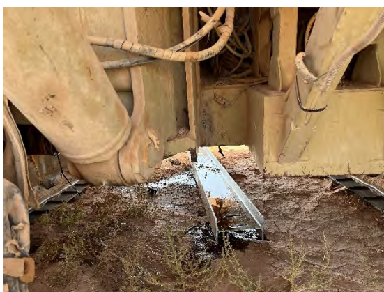
Figura 20 Vertido de líquido hidráulico
