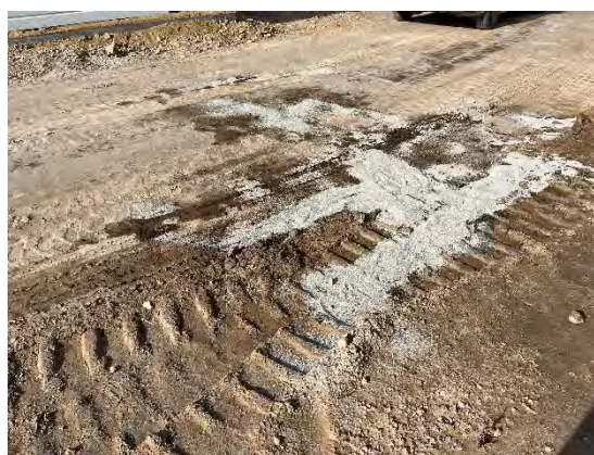
Figura 21 Aplicación de sepiolita
