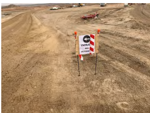
Figura 16 Señalización en obra
