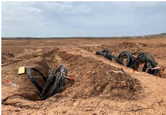
Figura 9 Tendido de cable de baja tensión
