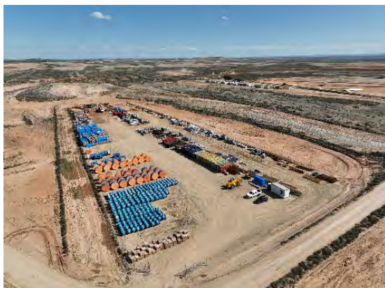
Figura 18 Zona de acopio del material de construcción
