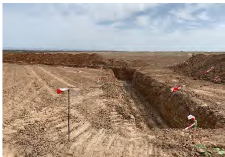
Figura 3 Apertura de zanjas
