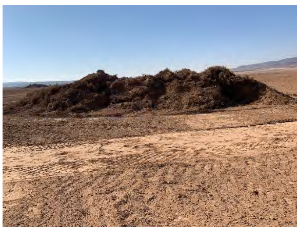
Figura 15 Acopio de tierra vegetal
