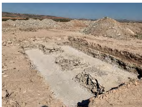
Figura 22 Trabajos de cimentación
