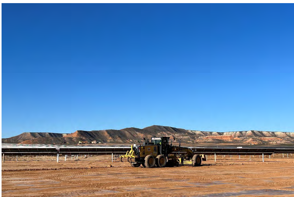
Figura 36 Nivelaciones del terreno
