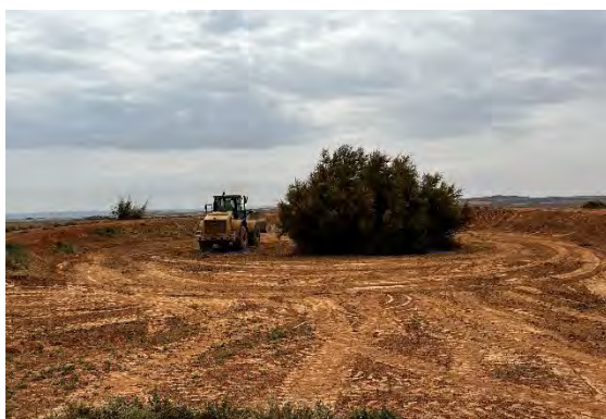
Figura 31 Restauración de los balsetes
