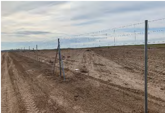
Figura 33 Instalación del vallado perimetral
