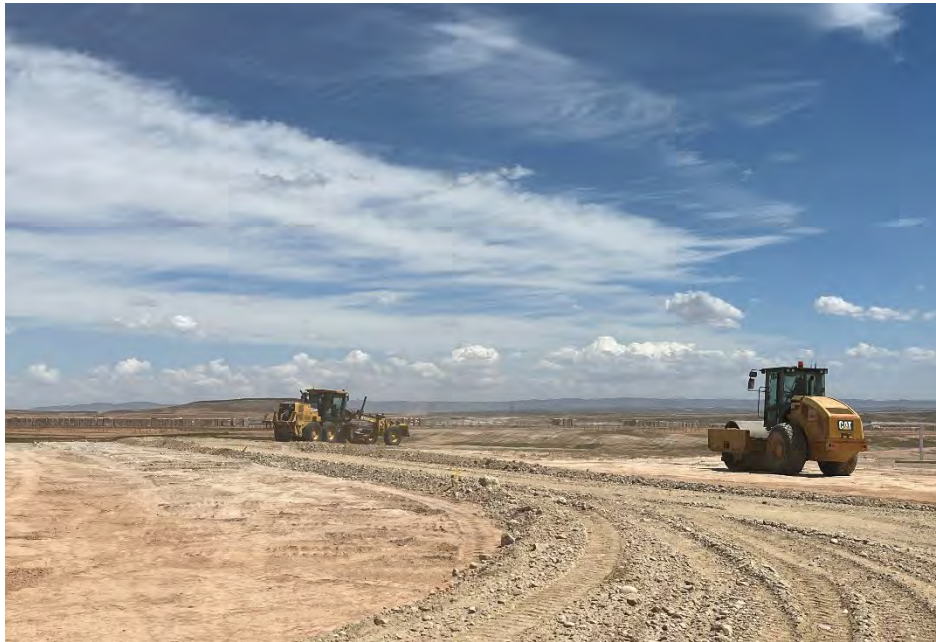
Figura 37 Apertura del vial interno
