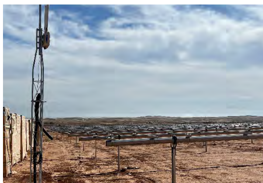
Figura 7 Montaje de los trackers
