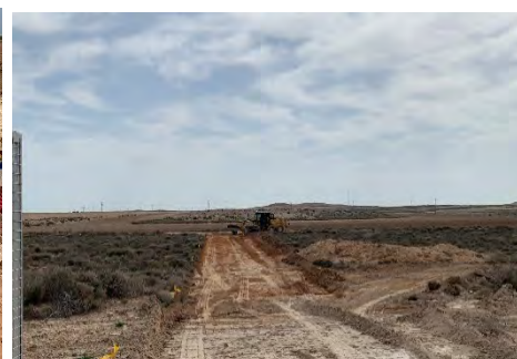
Figura 5 Apertura de viales
