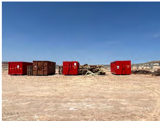
Figura 25 Punto limpio de residuos no peligrosos
