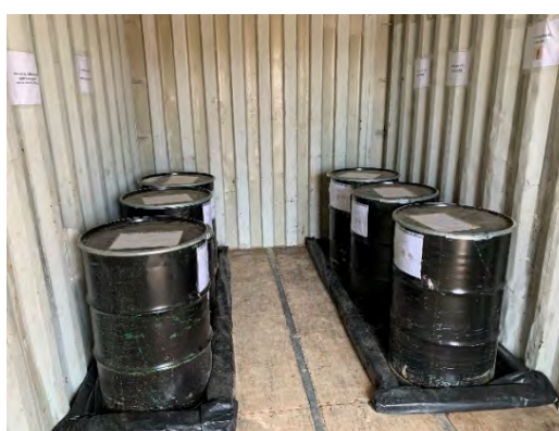
Figura 27 Punto limpio de residuos peligrosos
