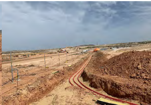
Figura 10 Tendido de cable de media tensión
