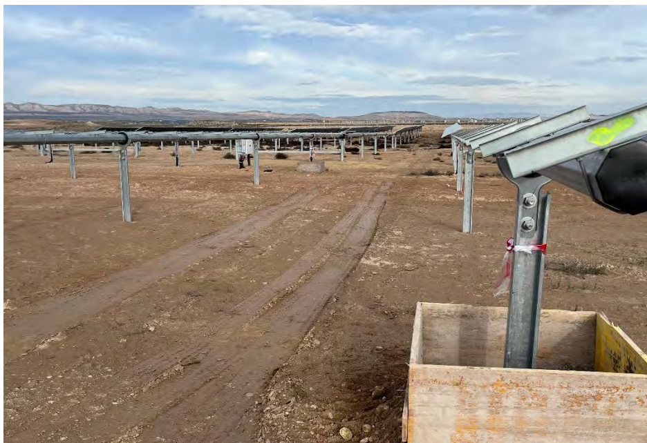
Figura 38 Encofrado para la cimentación de las hincas rechazadas
