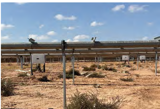
Figura 11 Montaje de los inversores
