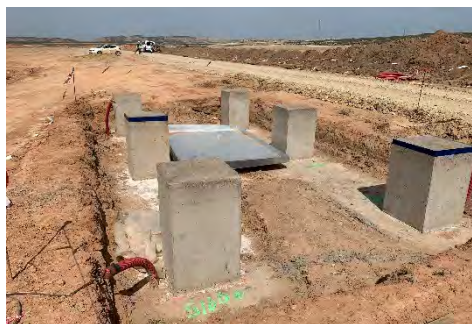
Figura 4 Trabajos de cimentación
