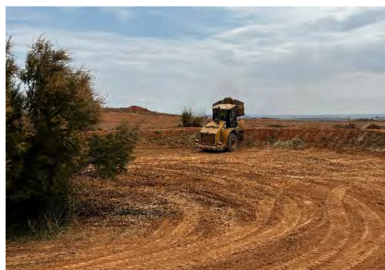
Figura 32 Restauración de los balsetes
