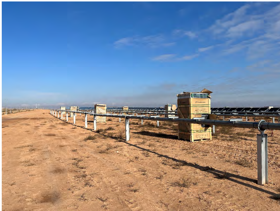
Figura 39 Montaje de los módulos
