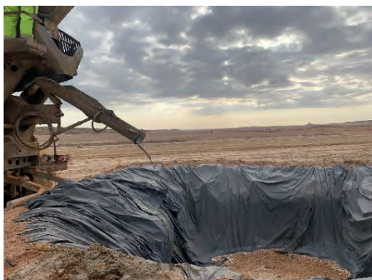
Figura 24 Lavadero de cubas de hormigón
