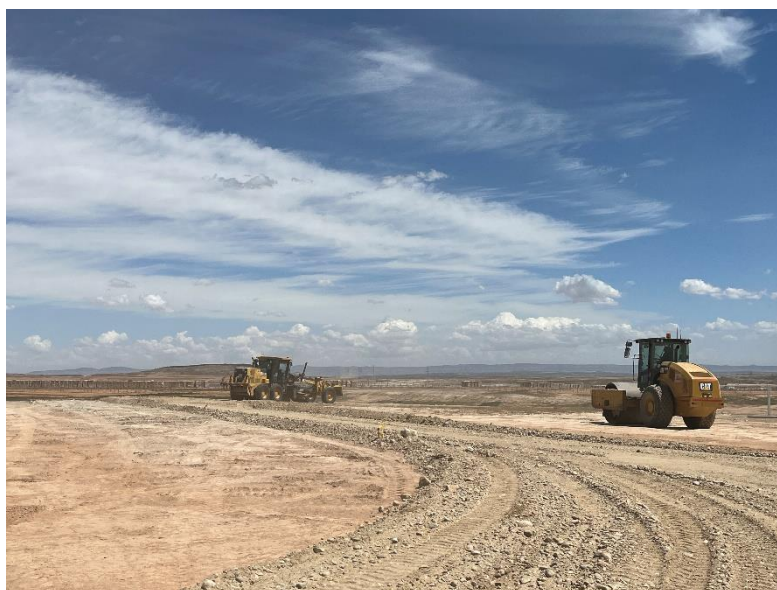
Figura 2 Apertura de viales
