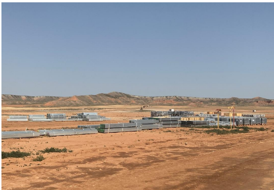
Figura 4 Zona de acopio de materia de construcción
