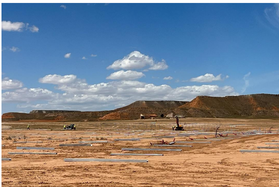
Figura 7 Labores de hincado
