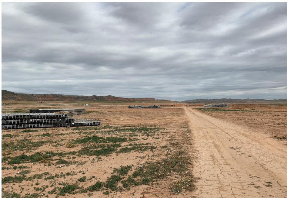
Figura 4 Zona de acopio
