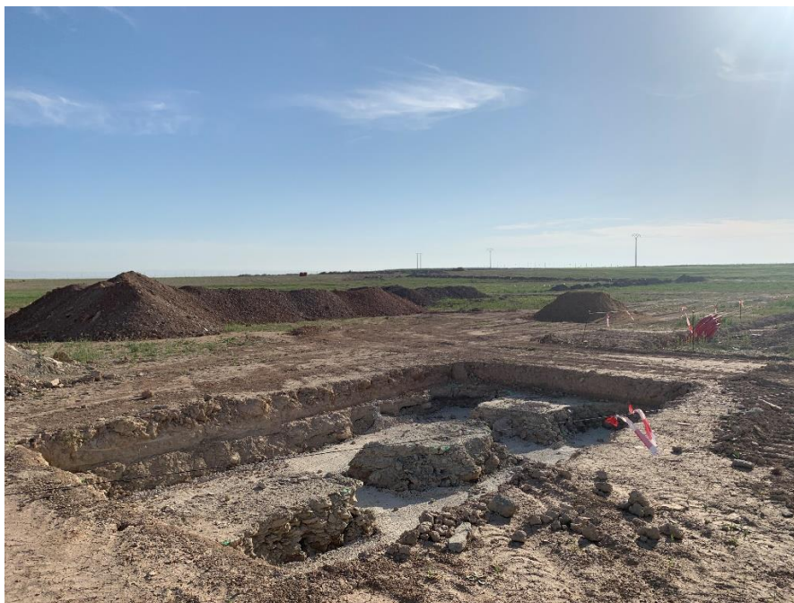
Figura 2 Cimentación de un CT
