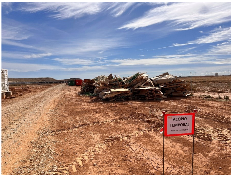
Figura 3 Acopio temporal de RNP
