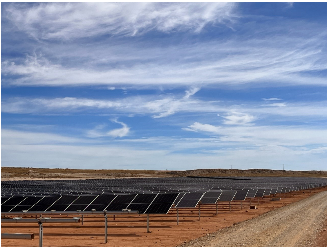
Figura 2 Montaje de los módulos fotovoltaicos
