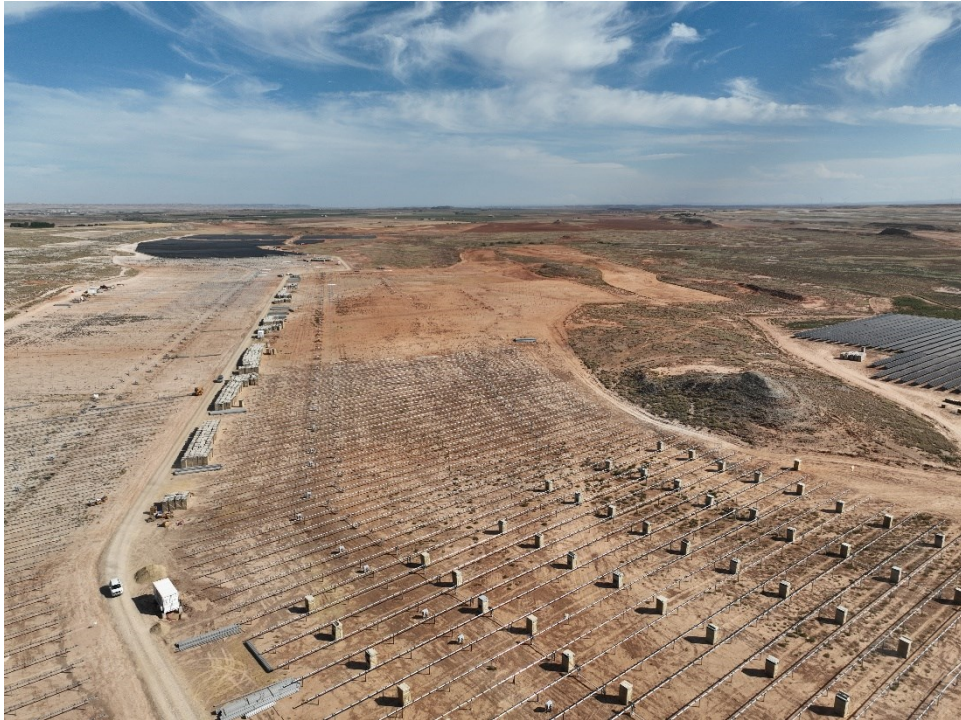
Figura 8 Vista aérea de la planta
