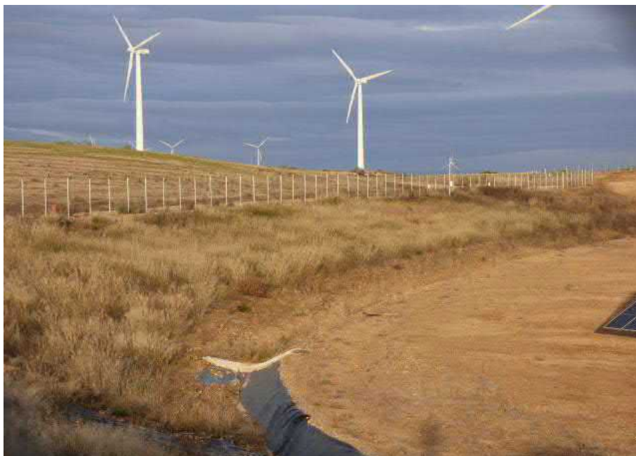
Imagen 2: Taludes interiores en los que el resultado de la hidrosiembra ha sido satisfactorio. Todas las superficie de los taludes presentan una cobertura homogénea de vegetación natural
