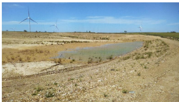
Figura 1.- Balsa de pluviales contigua a PFV.
