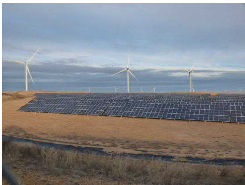
Imagen 4: El interior y el entorno de la planta fotovoltaica se mantienen en unas adecuadas condiciones de limpieza
