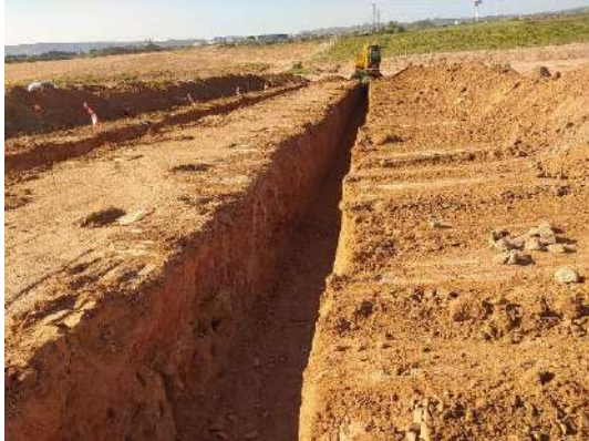
Fot 1. Y 2. Trabajos de zanjado de Baja Tensión en Zona 4 de PSFV Pitarco B
