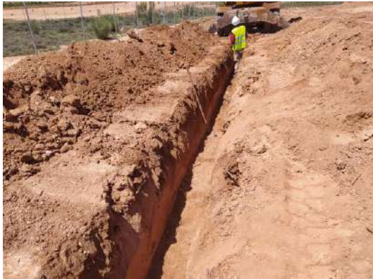
Fot. 3 y 4. Trabajos de zanjeado de MT en PSFV Pitarco B zona 3
