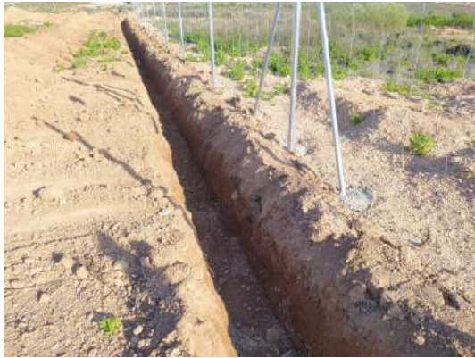
Fot 1. Y 2. Trabajos de zanjeado de CCTV en Zona 3 de PSFV Pitarco B
