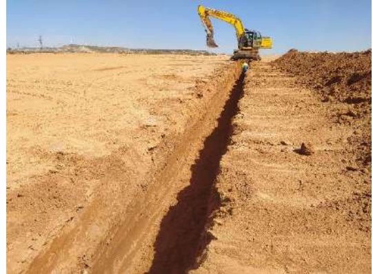
Fot 1. Y 2. Trabajos de zanjado de Baja Tensión en Zona 4 de PSFV Pitarco B
