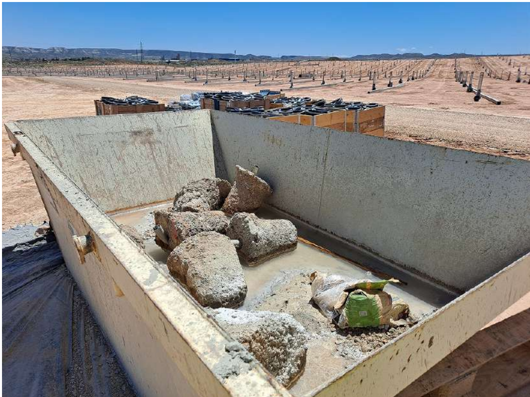
Restos de hormigón de cimentaciones retiradas
