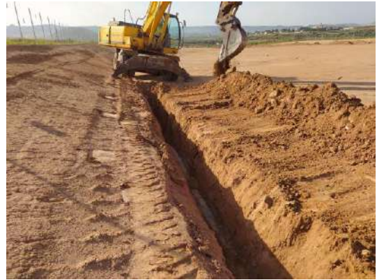
Fot 1. Y 2. Trabajos de zanjeado de CCTV en Zona 3 de PSFV Pitarco B
