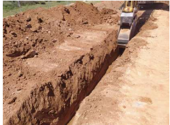
Fot. 3 y 4. Trabajos de zanjeado de MT en PSFV Pitarco B zona 3
