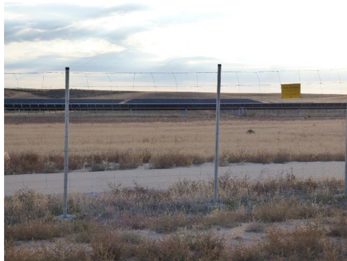
Imágenes 8, 9 y 10: Acumulación de Salosa kali en el vallado perimetral (izquierda y derecha). Vallado perimetral limpio de Salosa kali tras la aplicación de las medidas de mantenimiento (abajo).
