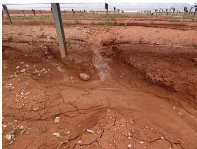
Imágenes 1 y 2 : Regueros locales de pequeña entidad bajolos paneles solares.
