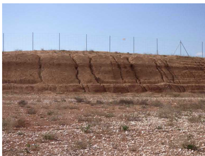
Imagen 1: Marca de erosión, en el talud sur del parque fotovoltaico "Híjar I".
