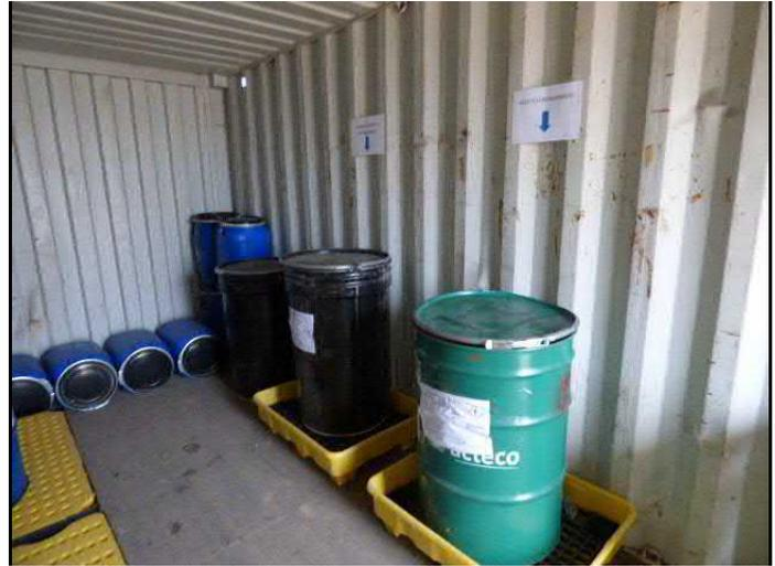
Imágenes 28 y 29: Depósitos homologados e identificados conforme a la normativa vigente para el almacenamiento de residuos peligrosos
