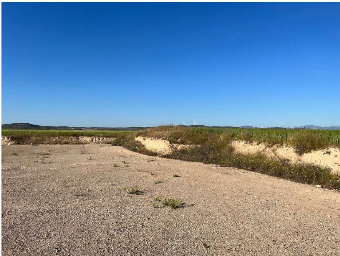
Imagen 7. Estado del talud anexo a la plataforma aerogenerador 7
