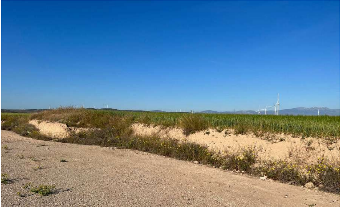
Imagen 15. Estado del talud anexo a la plataforma aerogenerador 7.
