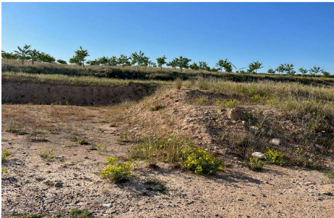
Imagen 9. Estado del talud anexo a la plataforma aerogenerador 4.
