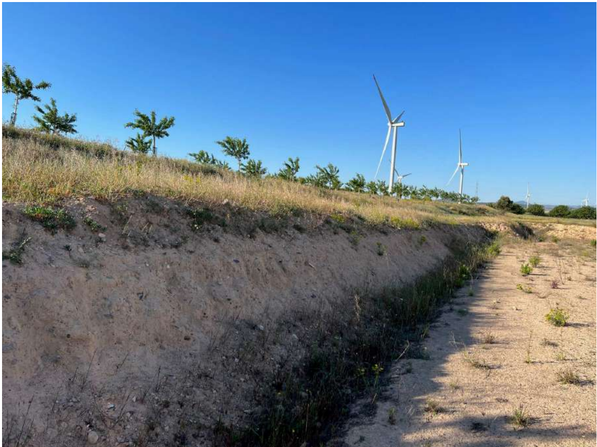
Imagen 8. Estado del talud anexo a la plataforma aerogenerador 4.
