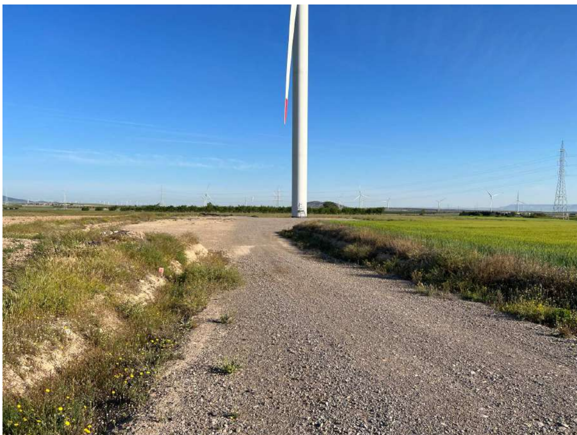
Imagen 10. Estado del talud anexo a la plataforma aerogenerador 4.
