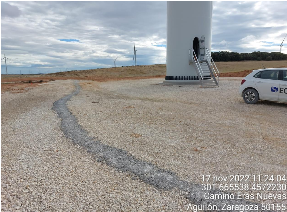
Imagen 2. Residuo de hormigón en SBII-6 que continúa por el vial de bajada.
