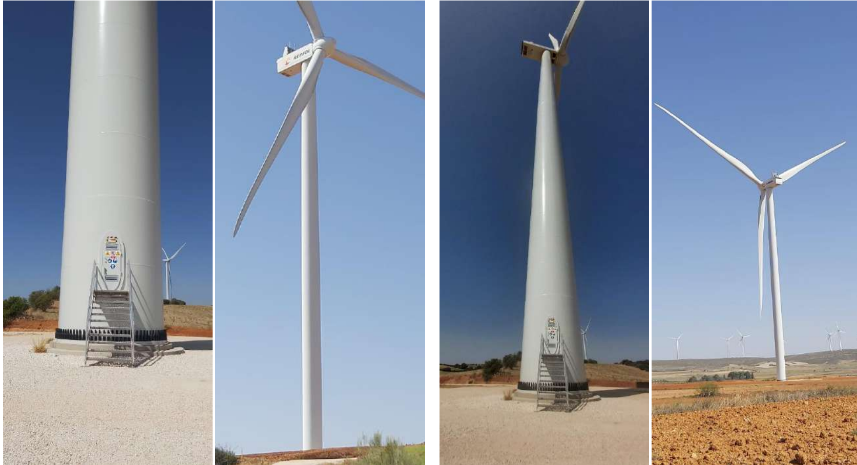
Fotografías 1 a 4: Estado de los aerogeneradores.
