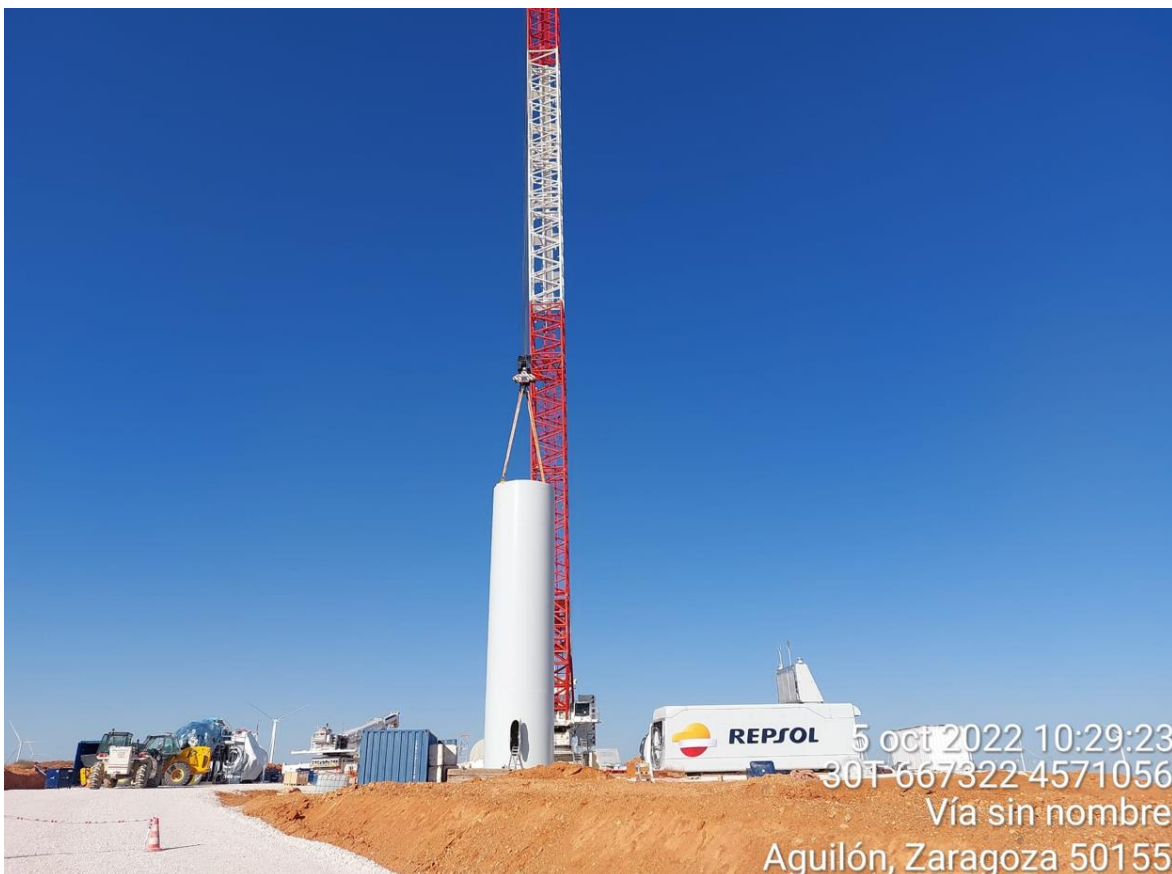
Imagen 4. Grúa colocando T1 en PLX-02.
