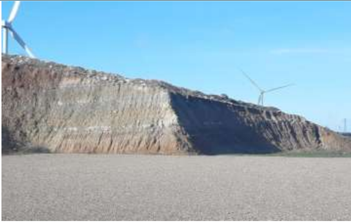
Fig. 1 Erosión hídrica en materiales margo-lutíticos del talud de desmonte de plataforma del aero ML4.02. Fuente: Elaboración propia
