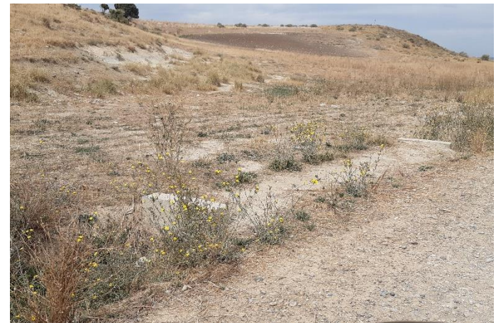
Fig.4 Tubo de drenaje semitaponado con vegetación arbustiva en vial de acceso al aero ML2.09. Fuente: Elaboración propia
