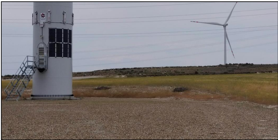
Fotografía 5. Pequeño talud junto a HE-02.
