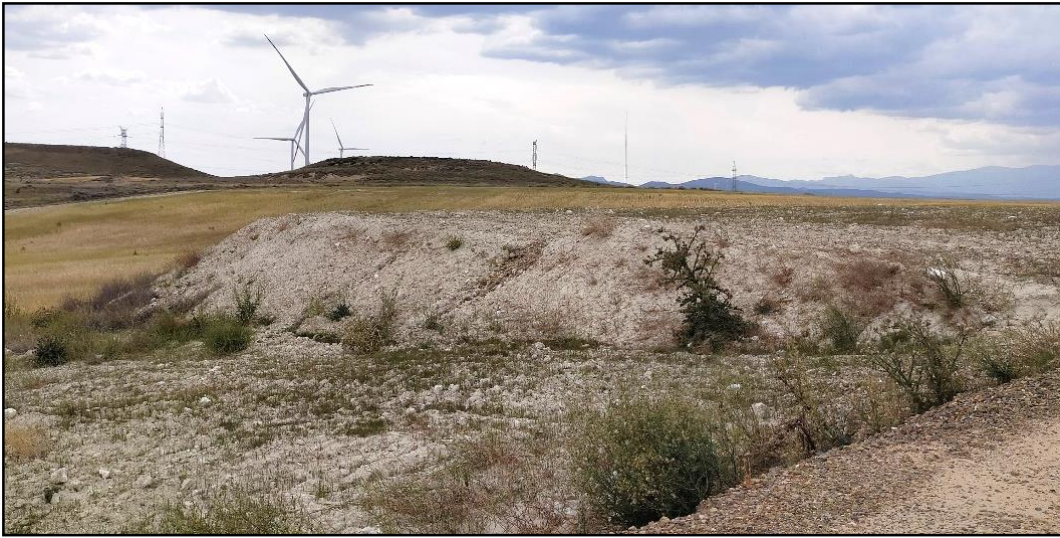
Fotografía 3. Talud sembrado con cierta recolonización vegetal natural.
