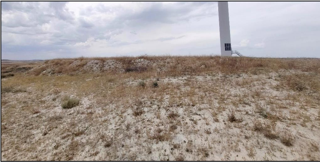
Fotografía 9. Talud con vegetación natural al sur de HE-04
