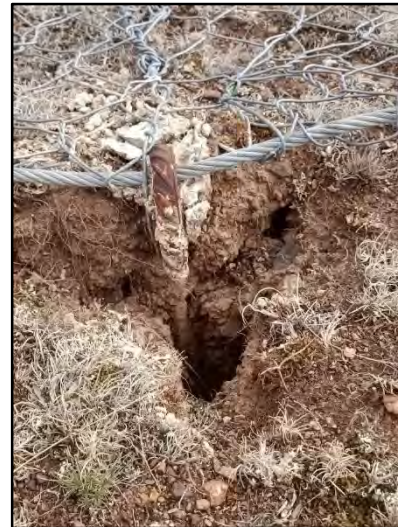
Fotografía 1. Malla de sujeción (izquierda) y detalle de un anclaje parcialmente suelto (derecha)
