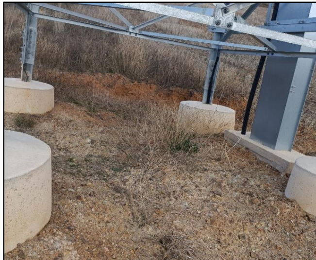
Fotografía 1. Naturalización y estabilización del terreno bajo la base del apoyo LCAS-01
