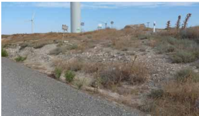
Foto 6. Talud en recuperación en Dehesa de Mallén
