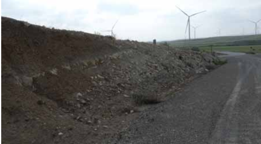
Foto 5. Cuneta en la plataforma y vial de acceso
