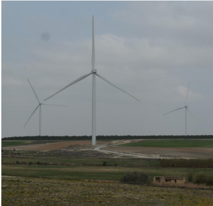
Aerogenerador del P. E. Dehesa de Mallén
