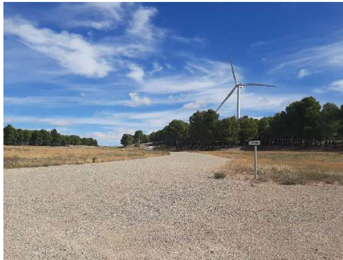
Vial de acceso al aerogenerador CAN-05
