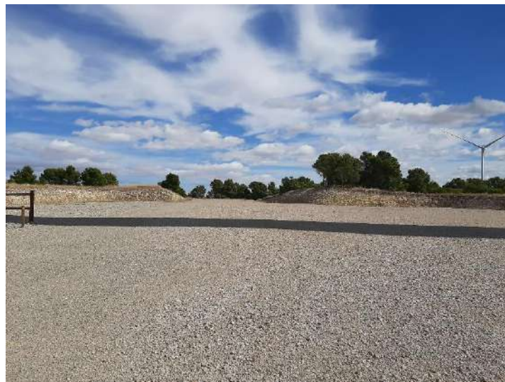
Plataforma del aerogenerador CAN-05
