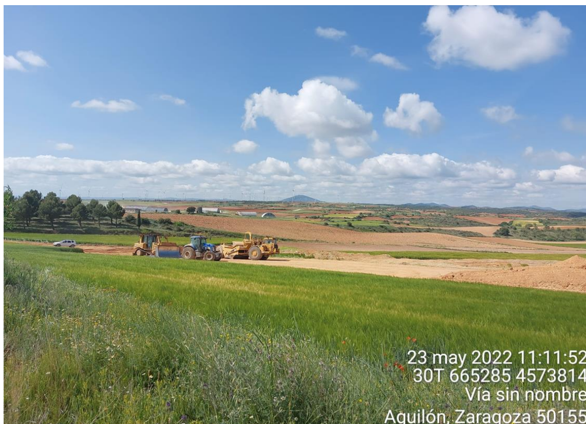
Imagen 1. Trabajos de movimiento de tierras en SBI-01.
