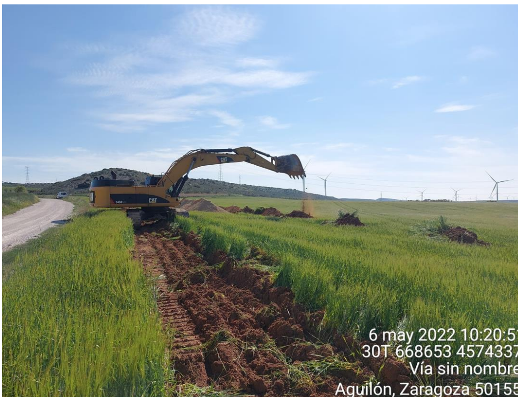
Ilustración 3. Correcta separación de la tierra vegetal en la zanja de la red de tensión.
