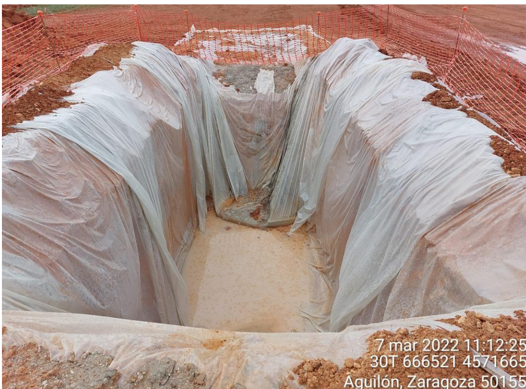
Imagen 3. Zona de lavado de SBII-10 que cumple los requisitos ambientales exigidos.
